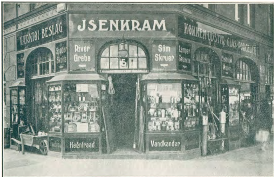
Sinius Larsens Forretning, Nordre Fasanvej 1.
