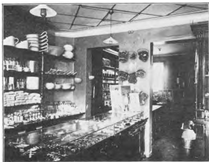
Interiør fra M. Thygesen Poulsens Forretning, Gl. Kongevej.
