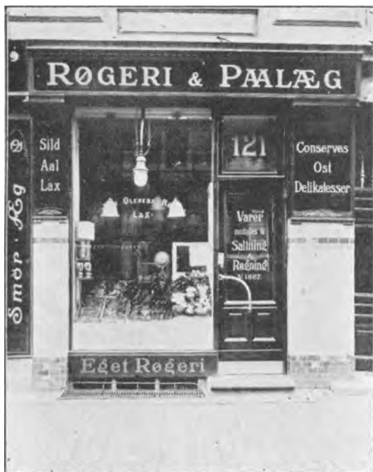
Firmaet Johs. Olesens Forretning, Istedgade 121.
