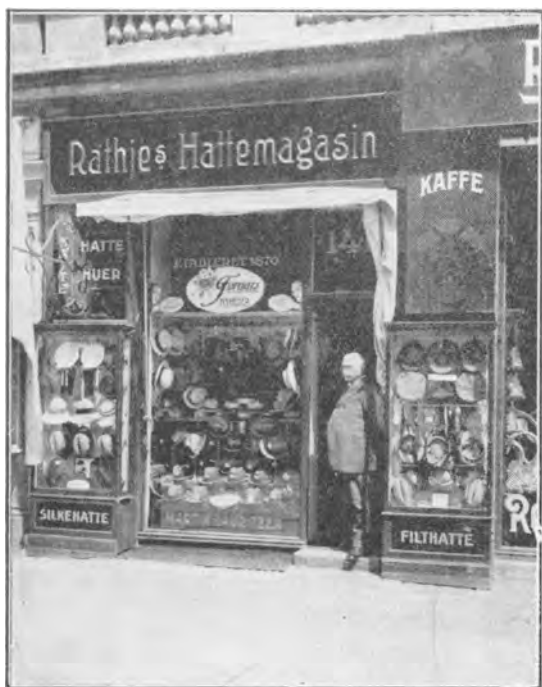
Rathjes Hattemagasin, Amagerbrogade 141.
