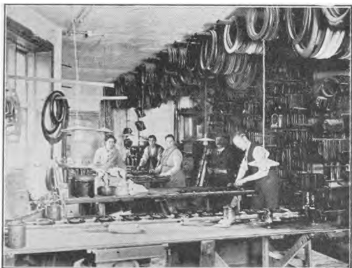
Interiør fra M. L. Andersens Rammefabrik.
