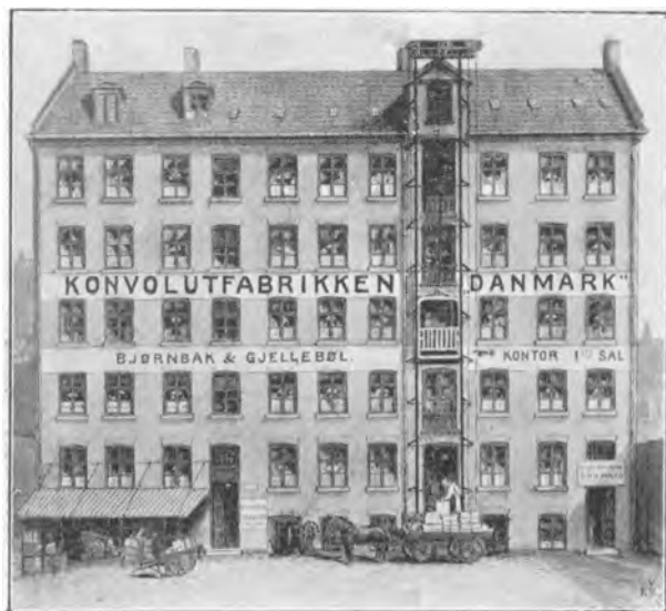
Konvolutfabriken Danmark før den store Udvidelse.
