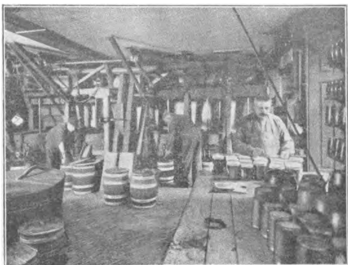
Interiør fra Firmaet W. Bähncke & Cos Fabrik.
