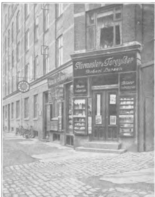
1902. Robert Larsens Forretning, N. Fasanvej 150.
