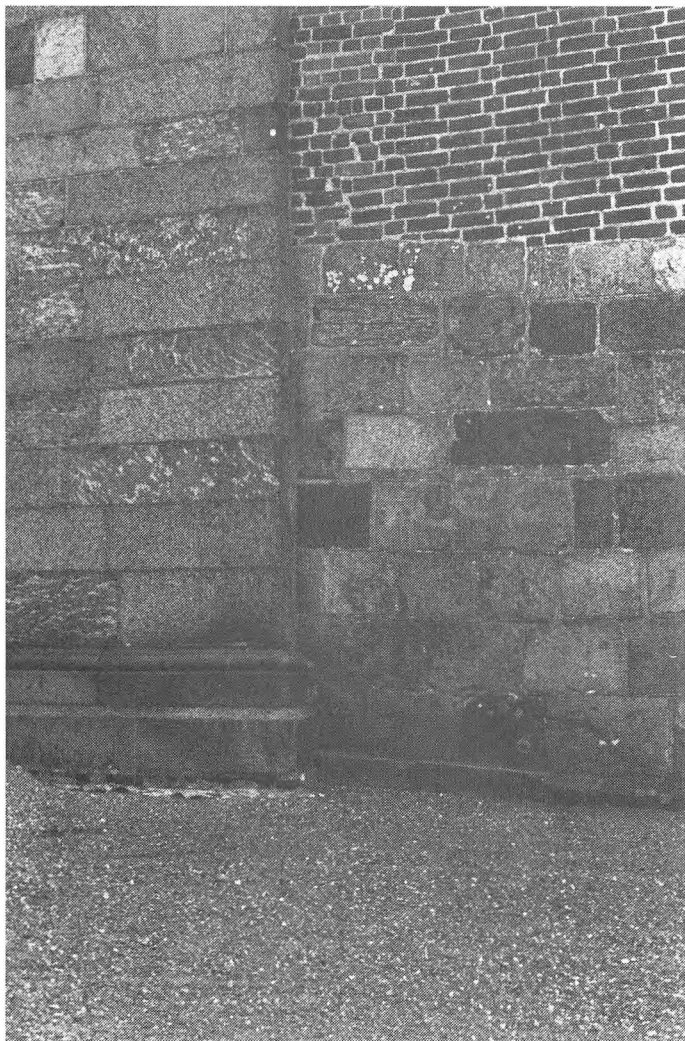
Tårnets tilslutning til skibet i Grinderslev kirke set fra nord. Forskellen mellem det omhyggeligt udførte romanske skib med smukt profileret dobbeltsokkel og det sletgjorte gotiske tårn er iøjnefaldende.
