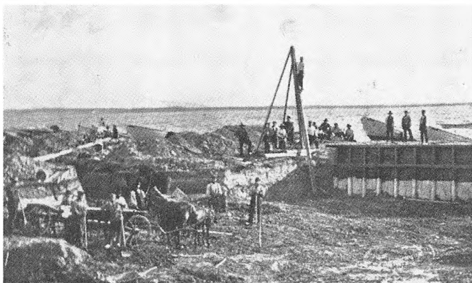
Havnebyggeriet i 1868 i Skive. Med rambukken er arbejderne ved at nedramme bolværkspæle til søndre mole i Sydhavnen. Havnebassinet udgraves i den gamle ladeplads' grund ved Krabbesholm. Der graves med skovl og jorden køres bort på hestevogne.
