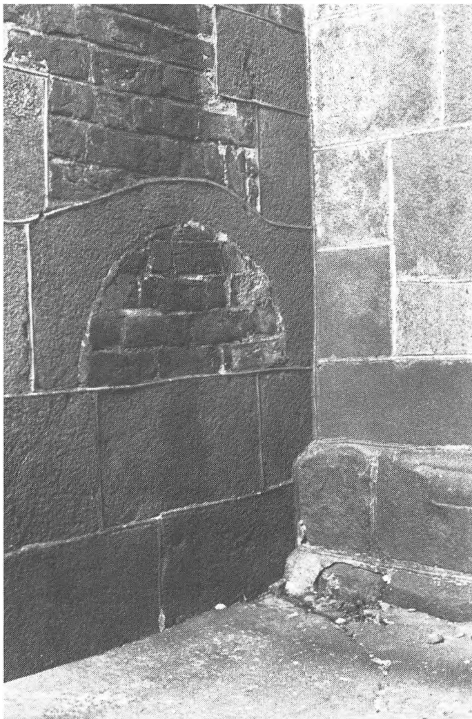
Rundhuet vinduesoverligger indmuret i Grinderslev kirkes nord-østlige sidebygning.
