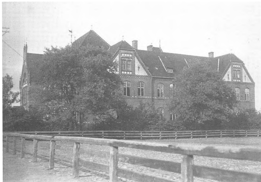
Amtshuset H. P. Hanssensgade 42 i Aabenraa – min arbejdsplads fra 1937 til 1975. Rud. Olsen fot. i Historiske Samlinger.
