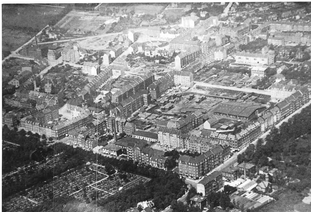
Udsigt over Trøjborg omkring 1932. I forgrunden hjørnet af Trøjborgvej og Dronning Margrethes Vej. Billedet illustrerer tydeligt kvarterets bebyggelsesform, karakteriseret ved etage- og karrébyggeriet med enkelte fabriksbygninger og industrivirksomheder isprængt. Læg blandt andet mærke til Aarhus Ny Trælsthandel (midt i billedet) og Jyllands Papir-værk (øverste til venstre). Som det ses, var kvarteret var endnu ikke fuldt udbygget, hvilket først skete i løbet af 1950'erne. Foto i Lokalhistorisk Samling.
