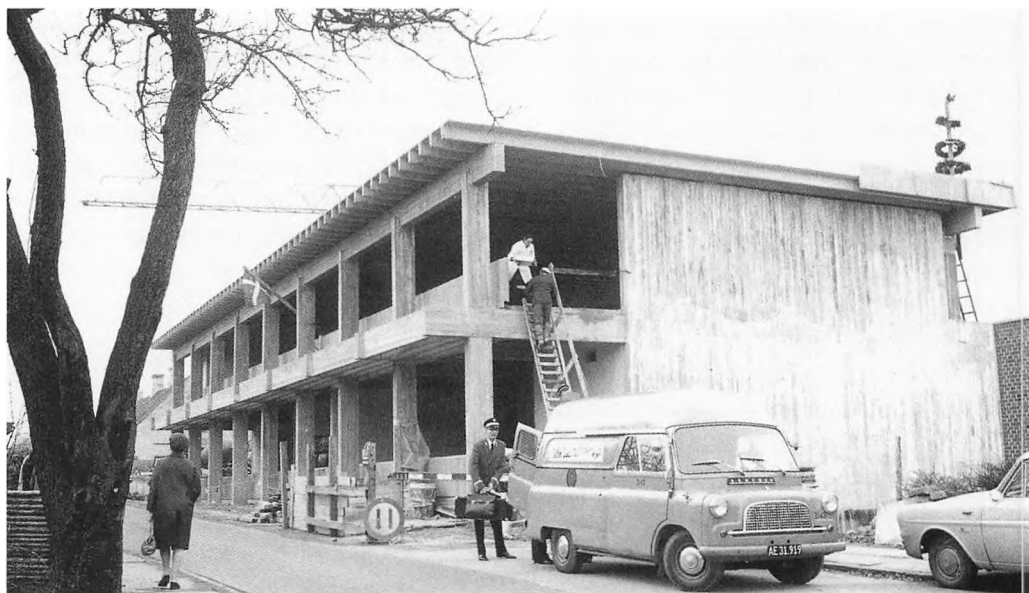
I 1968 fejrede man i Vejlbys rejsegilde på Apotekerfondens markante betonbygning på landsbyens hovedgade Vejlbysgade. I den bevarende lokalplan fra 1995 kommenterede man netop den negative virkning af de mange forskellige stilarter og materialer, som byggeriet her har bidraget til. Ved opførslen var Apotekerfondens bygning dog helt i overensstemmelse med tankerne bag dispositionsplanen for Vejlbys fra 1969. Foto af Per Allan i Lokalhistorisk Samling, Århus.
