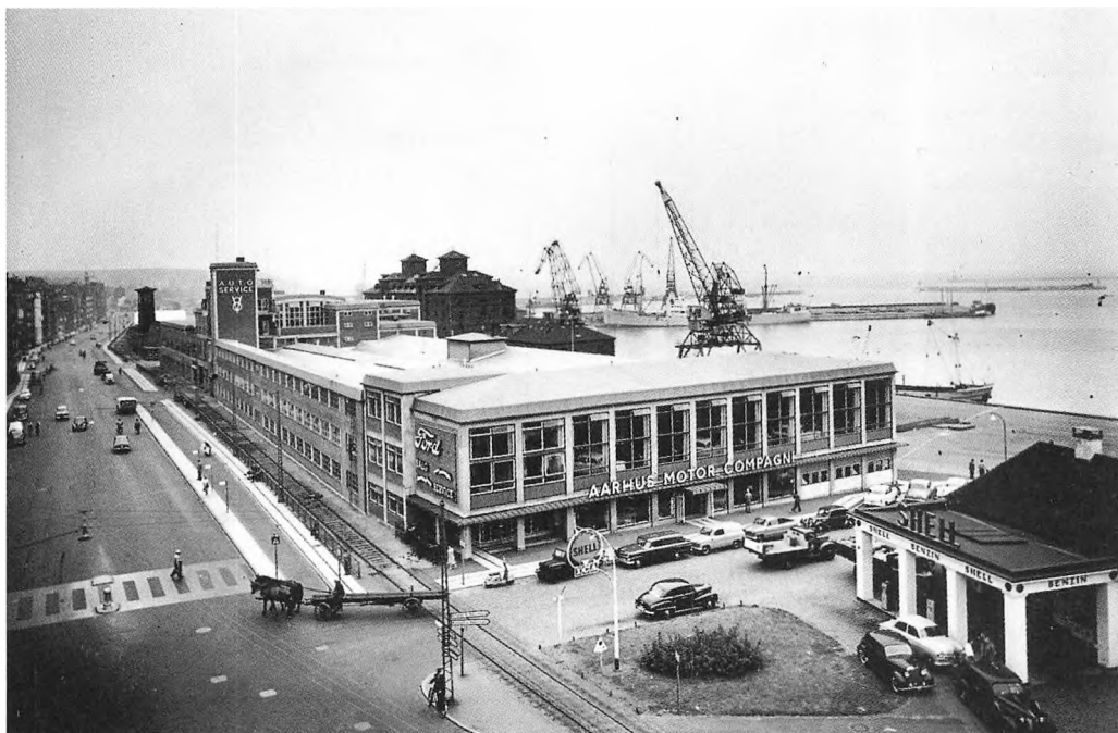
Det imponerende bilhus på Havnepladsen, der blev indviet i 1937( og nedrevet 1999), ses her på et billede fra 1955. Nord for bilhuset ligger maskinfabrikken i tre etager. Den blev bygget i årene 1948-1951. Den store bygning bag Ford-komplekset er Korn og Foderstof Kompagniets foderblandingsfabrik Karens mølle. Bilerne var endnu ikke enerådende i byens trafik på dette tidspunkt, som det fremgår af køretøjet i krydset. Foto i Lokalhistorisk Samling, Århus.
