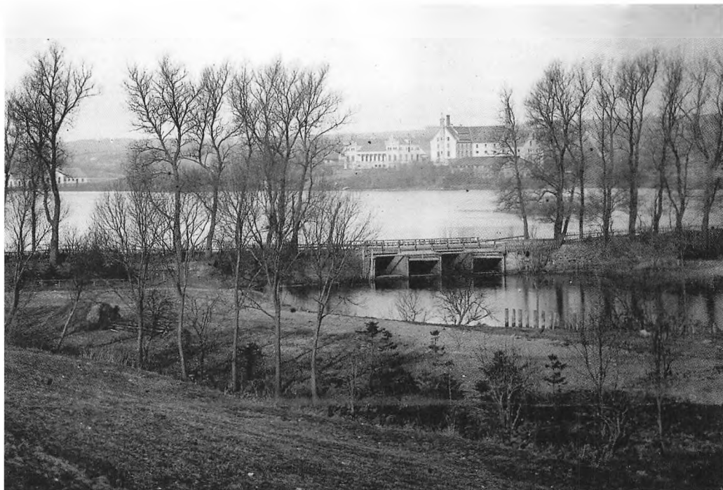
Udsigt over Århus Å med Slusebroen mod Bryggeriet Ceres. Vejen over broen er Vester Allé, og bag den ligger mølledammen, hvis størelse blev kontrolleret ved hjælp af sluserne. I 1873 opgav møller Weis retten til at opstemme vandet og i stedet opstod de sumpede mølleenge, der på grund af byens kraftige udvidelser sidst i 1800-tallet udviklede sig til at blive attraktive byggegrunde. Foto i Lokalthistorisk Samling, Århus.
