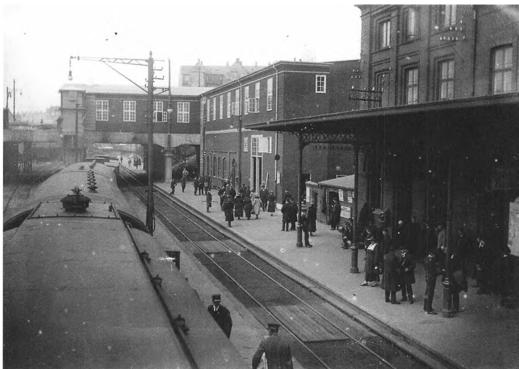
Den midlertidige stationsbygning fra ca. 1922-29, set fra perronen op mod den nye Bruunsbro, kort efter opførelsen og før nedrivningen af den gamle banegård, hvis overdækkede perron ses forrest i højre side. Foto i Lokalhistorisk Samling, Århus.
