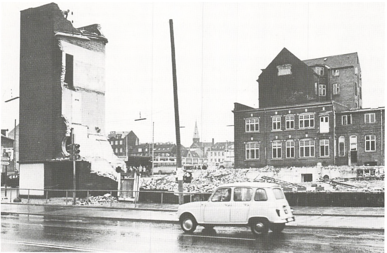
Efter at Sabroe i 1969 havde flyttet også administrationen til Holme, overtog kommunen fabriksområdet. En kort tid havde bl.a. Teknisk Skole lejemål i bygningerne, men fra 1970 blev området efterhånden ryddet og delvis udlagt til parkeringspladser. Siden 1983 har det været hjemsted for den nye politigård.
