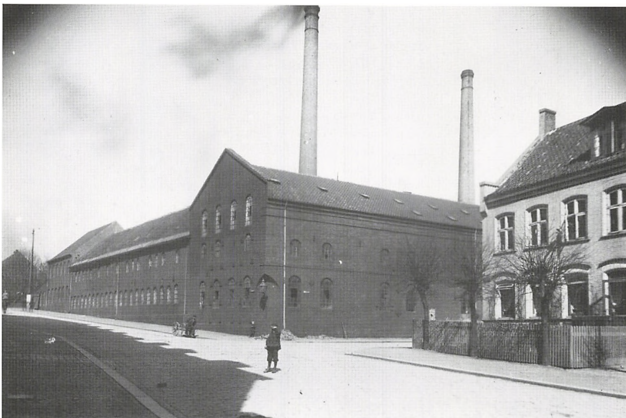
Fabrikken set fra Sønder Allé ved hjørnet af Amaliegade omkring århundredskiftet. Nogle år efter udflytningen til Åbyhøj blev fabriksbygningerne revet ned, og 1918-21 opførte A/S Fotorama med A. Høeg-Hansen som arkitekt det stadig eksisterende Regina-kompleks.
