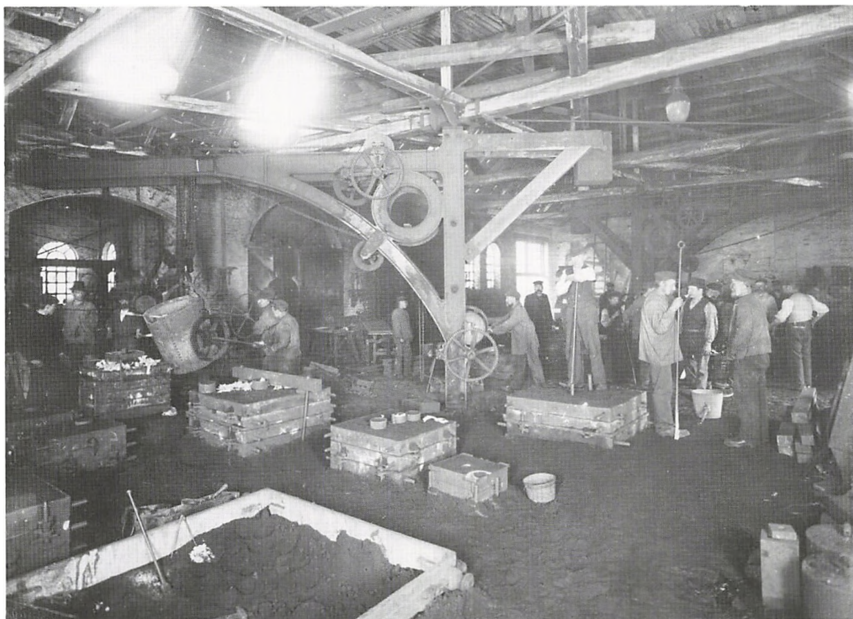
Interiør fra jernstøberiet omkring 1904 giver et godt indtryk af de store og mørke fabrikslokaler. Her arbejdede fabrikkens mange støberiarbejdere, rensere og formere. De mekaniske hjælpemidler var – som det ses – beskedne.
