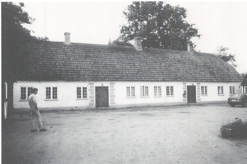
III. 38. Stuehuset til Visbjerg i Balslev sogn på Vestsyn; ca. 40 tdr. land. Bygningen er fra 1845-47; den havde oprindeligt stråtag, men fik det omlagt til cementsten 1913; OBM.
