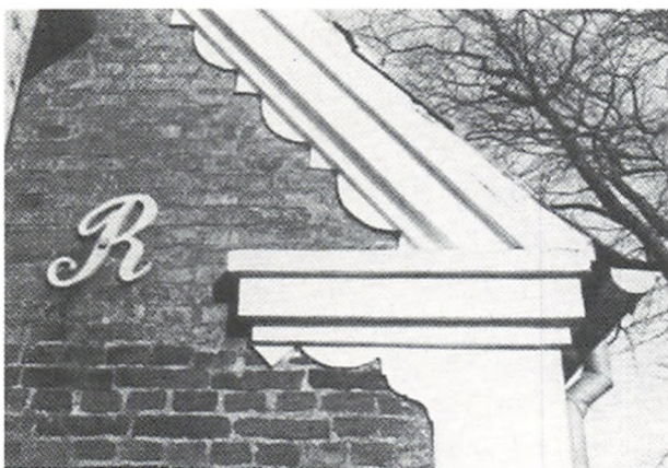
III. 58. To former for gavludsmykninger på Esbjergegnen omkring 1880: Den tungede gesims var brugt af alle lokale bygmestre i perioden, renæssancegavlen på Ølgaard i Gammelby fra 1881 var Søren Frederiksen „Moses“ første bygningsværk efter en tur til Amerika; Dragsbo 1983.
