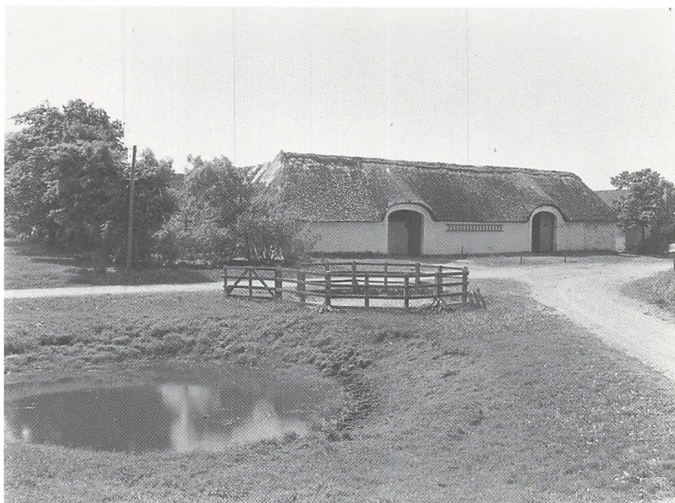
III. 42. Grundmuret lade med høje tværporte med murede portaler på en gård i Hillerup ved Ribe; foto på Nationalmuseet, her efter Højrup, 1960.
