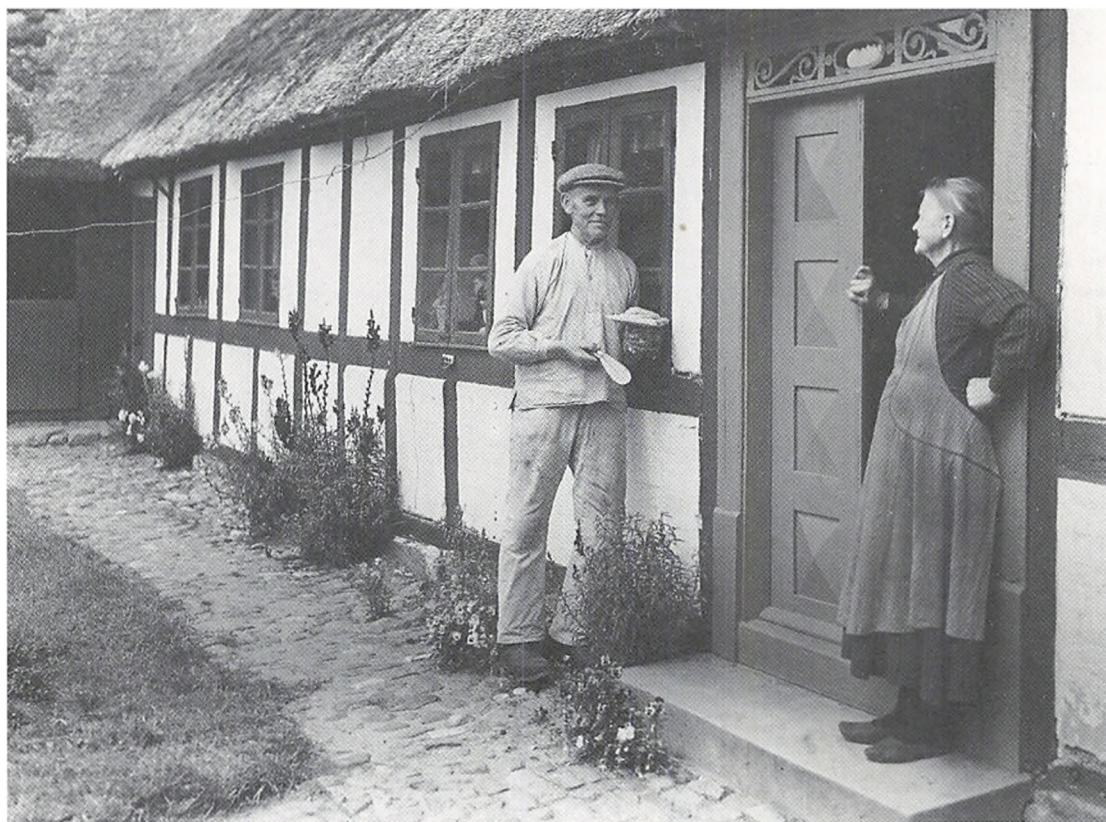
III. 11. Opstilling med „huskone“ og spækkemand. Bindingsværksbygningerne kræver årlig vedligeholdelse - bl.a. fordi træ- og murværket ikke „arbejder“ på samme måde; OBM, ukendt oprindelse.
