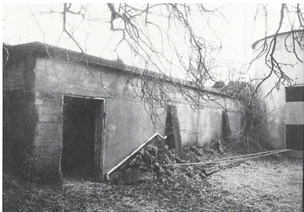
III. 120. Roehus af beton (til venstre - alder ukendt) og ensilagebeholder af teglsten og cementpuds (fra 1947) ved Tinggaard (50 tdr. land) i Guldbjerg på Nordfyn. Terrænet bag de to bygninger ligger i niveau med roehusets tag, hvilket lettede opfyldningen.
