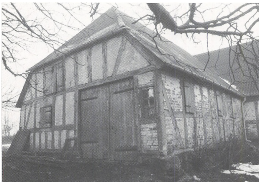
III. 48. Firkantet hestegangshus fra 1878 ved gård i Skovstrup, sydvest for Odense. Bygningen er tilbygget laden og rummede ved Gårdprojektets besigtigelse i 1986 både hestegangsværk og tilhørende kværn; OBM.
