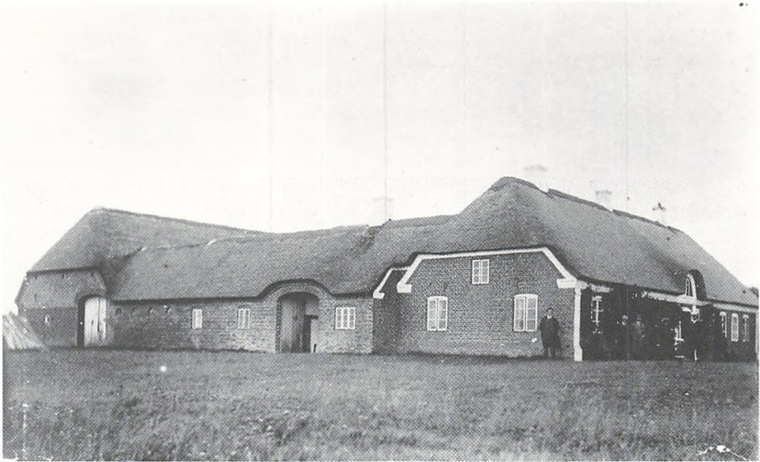
Ill. 28. Carl Bollerups gård i Rindom ved Ringkøbing, bygget i 1857 og opmålt og fotograferet af Nationalmuseet i 1907. Gården var, ifølge Ole Højrup, opmuret af rødbrune teglsten, der var brændt på egnen i en primitiv oven, hvis ujævne varme havde givet stenene et smukt farvespil; Nationalmuseet.
