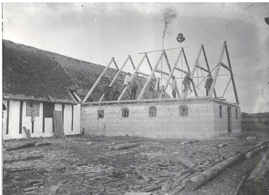
Ill. 65. Rejsegilde på „søndre kostald“ i 1899 på Risegård i Åker, Bornholm. Bygningen var opført med vægge af beton; Bornholms Museum.
