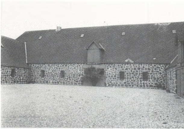
III. 31. Kampestensbyggede udlænger til Mindegård (6 tdr. htk.), Dalby sogn på Hindsholm. Udlængerne er opført 1883-85. Det oprindelige stråtag udskiftedes med asbestskiferplader i 1932; OBM.
