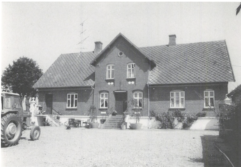
Ill. 98. Stuehuset til matr. nr. 1 i Slagstrup. På taget ses de tykke „diagonalsten“ af cement, som blev meget udbredte på Fyn i de første årtier af 1900-tallet - og som viste sig at have stor holdbarhed; OBM.
