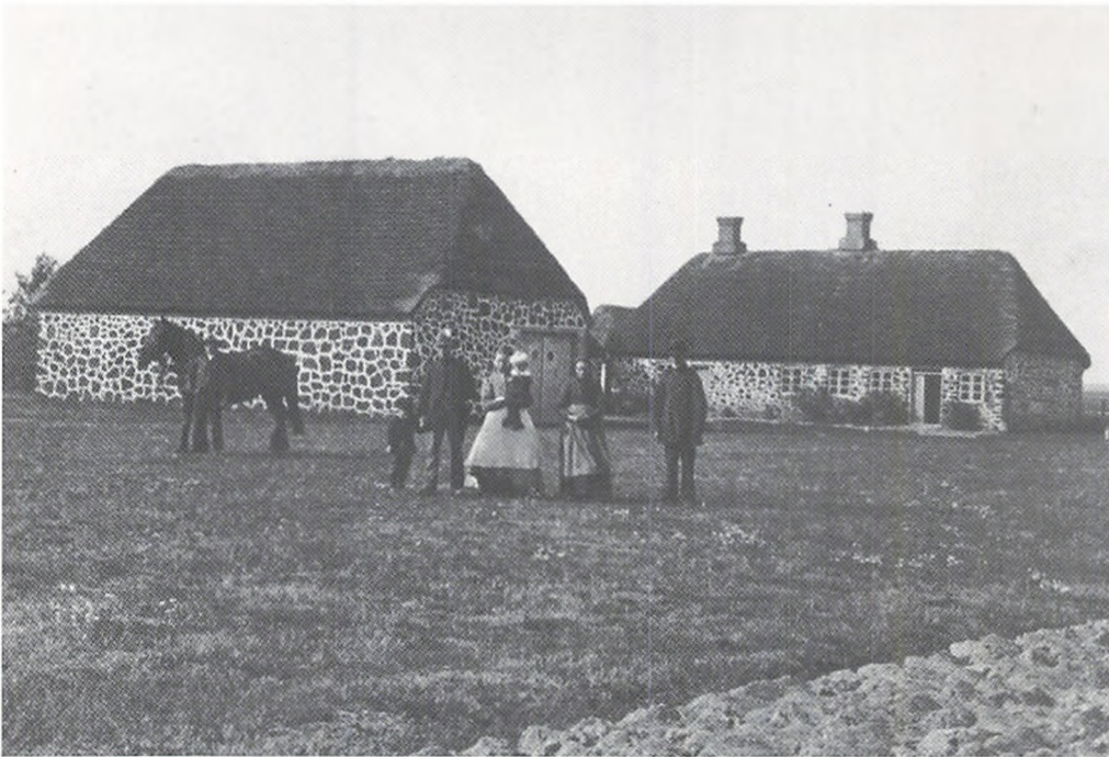
III. 32. Ejendom i Vester Tulstrup, Ikast sogn, opmuret i myremalm i 1897; fotografet af C. Birkmose; original på Herning Museum.
