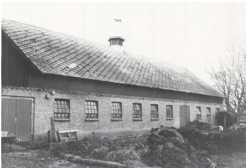
III. 118. Velbevaret stald fra 1931 på Lykkenseje (20 ha.) ved Gislev på Østfyn. De store vinduer skulle borge for dagslyset i stalden og ventilations-skorstenen viser, at man også tænkte på udluftningen. Der er imidlertid ingen luftventiler, og specielt i vinterhalvåret var vippevinduerne højt uegnede til frisklufts-indtag; OBM.
