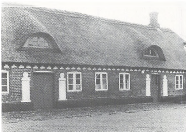
III. 36. Nederbygård i Sønder Felding sogn med sorttjæret sokkel, hvide vinduer, pilastre og hvidmønstreret gesims mod de røde mursten. Steensberg daterer stuehuset til tiden umiddelbart efter 1850. Bemærk de flade græstørv på mønningen; efter Steensberg 1978.
