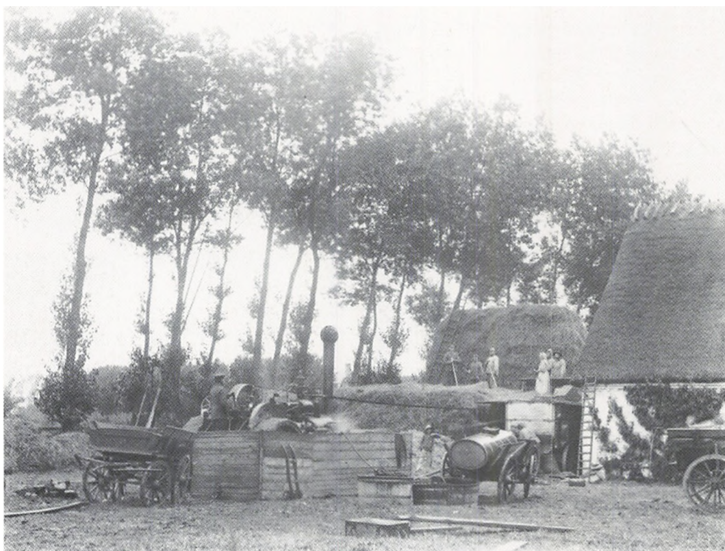
III. 122. Lokomobilerne blev endnu brugt et godt stykke op i mellemkrigstiden nogle steder. Her tærskes der på Elkærgård i begyndelsen af 1900-tallet. Værket var anskaffet i fællesskab af bønderne i Dræby, Munkebo og Drigstrup. „Lars Fyrbøder“ passede lokomobilen; ajletønden leverede vand til kedlen – og til en evt. brandslukning; fotograf Lars Rastrup; original på Kerteminde Museum; her efter Porsmose 1989.
