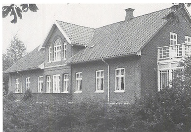
III. 41. Stuehuset til Christiansborg fra 1900 skulle også være Vilhelm Smiths værk - i så fald én af de sidste. Både denne gård og Nellerodgård ligger på Vestsfyn; Dragsbo 1993.
