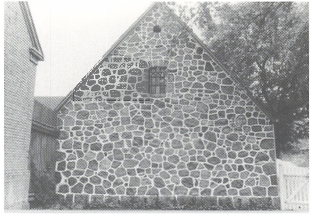
III. 31. Kampestensbyggede udlænger til Mindegård (6 tdr. htk.), Dalby sogn på Hindsholm. Udlængerne er opført 1883-85. Det oprindelige stråtag udskiftedes med asbestskiferplader i 1932; OBM.
