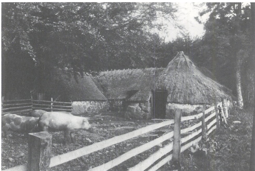
III. 24. Denne imponerende trelængede svinesti af tilhuggede kampesten blev fotograferet af K. Uldall fra Nationalmuseet i 1927. Anlægget lå ved Brændskovgård i Gudbjerg sogn på Sydlyn. Broholm gods skulle angiveligt have brugt bygningen til nattesæde for svin, der gik på olden; Nationalmuseet.
