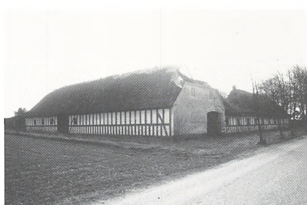
III. 43. Agerumslade på Søndergård i Brylle (godt 6 tdr. htk.) på Fyn, opført ved gårdens udflytning i 1867 i bindingsværk, men med murede gavle. Denne velbyggede lade var i forfald, da Gårdprojektets besigtigelse fandt sted i 1986, og er i dag nedrevet; OBM.
