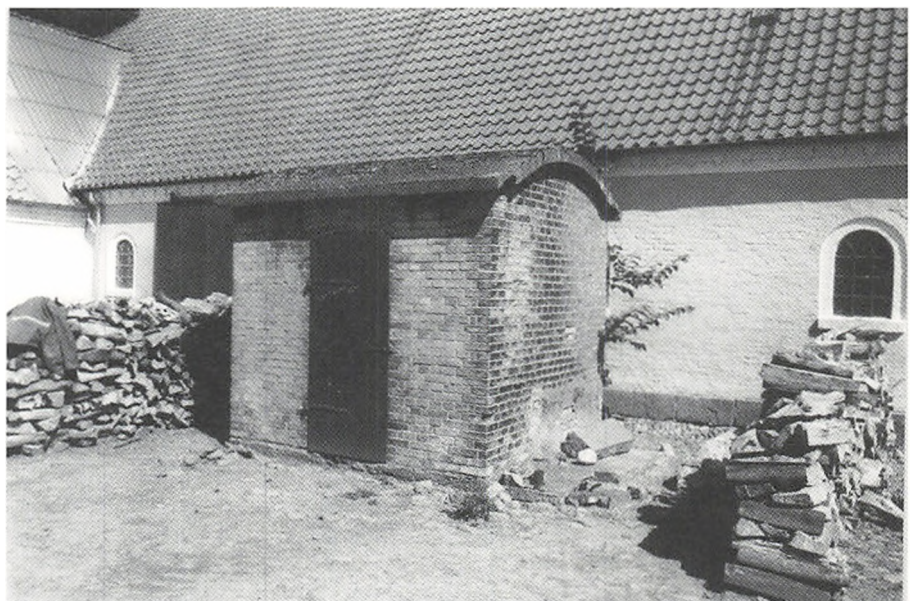
Ill. 124. Motorhus med jerndør og betontag opført ca. 1910 på Vestergård (70 tdr. land) i Svendstrup på Nordfyn; OBM.
