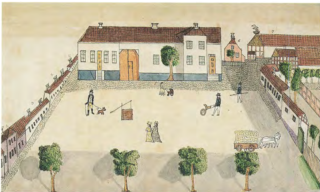
Barber Dragheims sygehus på Hjultorvet, tegnet af C. Gullew. Hele Dragheim familien deltog i pasning og pleje af patienterne, og når fru Dragheim havde vaskedag, spændte hun snore på tværs af torvet for at kunne tørre sengelinned.
