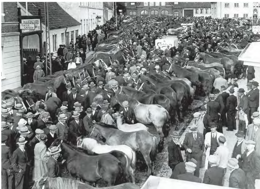
Hestemarked i Gravene, september 1939. Mænd og heste tætpakket fra brandstationen og helt ned til teateret. Markedsdagene gav også travlhed i de mange små tilrøgede værtshuse i handelsgaden.
