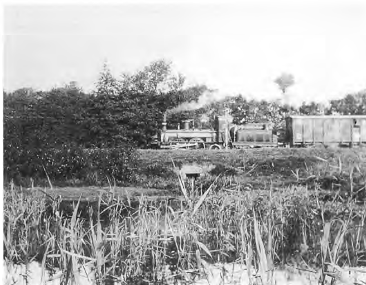
Viborgs banegård fra 1863 til 1896 lå ved Søndersø, på arealet nedenfor, hvor Søndersøparkens festsal ligger. Sporene løb langs søbredden og det gamle banelegeme tjener i dag som vandresti.
