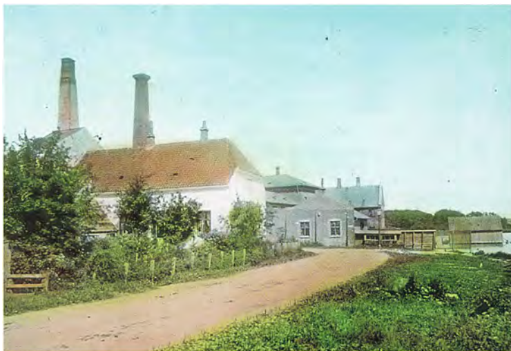
Sandbergs Brændevinsbrænderi ved Søndersø. Tidligere var der garveri i bygningen. Beliggenheden havde den fordel, at det var let at slippe af med spildevandet. I baggrunden sindssygehospitalet med vaske- og badehus i søkanten. Håndkoloreret glasplade. 1890.
