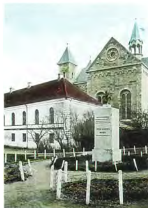
Stænderhuset, der var mødested for de nørrejske stænderforsamlinger. Mødesalen lå på første sal i vestenden. Håndkoloreret glasplade ca. 1868, hvor den nye domkirke er under opførelse.
