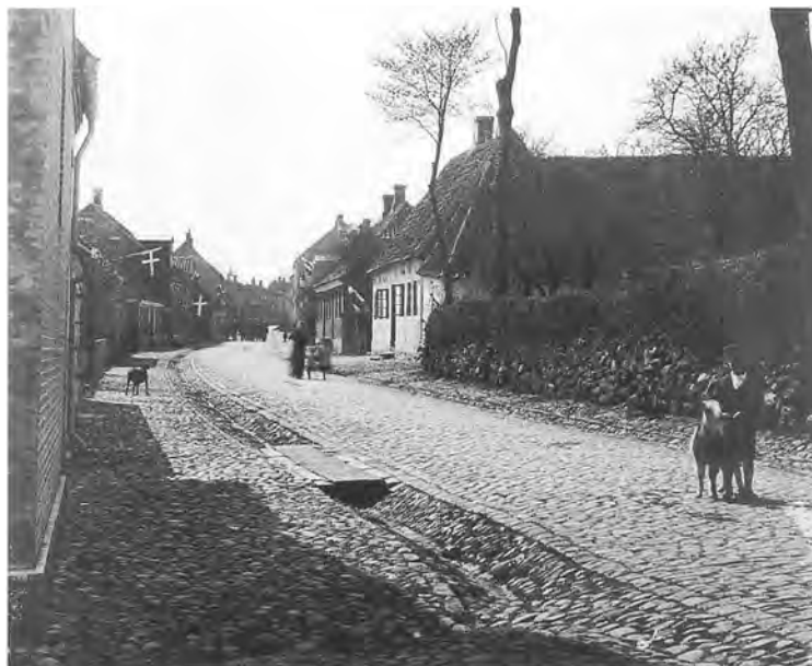
Sct. Ibs Gade 1903. For at undgå at træde i de åbne rendesten anbragte mange brædder på tværs. Den store forbedring af sundhedstilstanden i byen kom først med en ordentlig kloakering og det fælles vandværk fra 1900.
