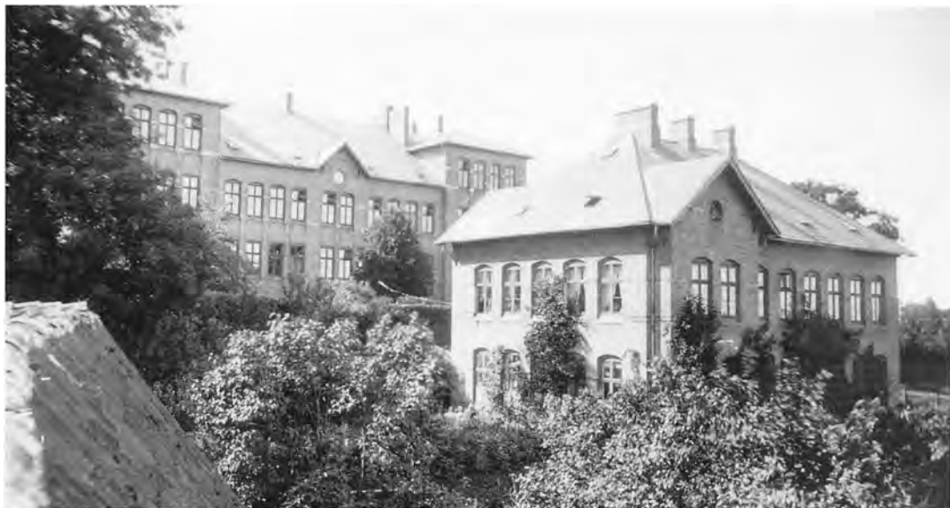
Borger- og Friskolen i Rosenstræde, tegnet af arkitekt Carl Lange. Bygningen var et typisk »skolepalæ« med et midterparti i to etager og to svagt fremspringende gavlparterier i tre etager. I 1915 hævede man midterpartiet op til tre etager, og skolen blev nu til en massiv bygning, der ragede voldsomt op over bydelens lave huse. Den mindre bygning rummede skoleinspektørens lejlighed og Borgerskolens tre pigeklasser.
