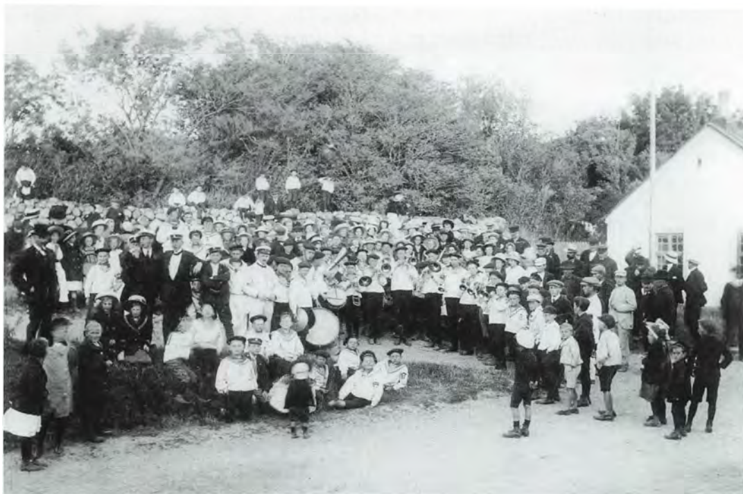
FDF på tur til Fur i 1913. FDF'erne dominerede i mange år bybilledet, men mødte dog konkurrence fra Det danske Spejderkorps. Blandt lederne i starten hos sidstnævnte var forfatteren Torry Gredsted, der netop på spejderture på Viborgegnen hentede inspiration til drengebøgerne om »Paw«.
