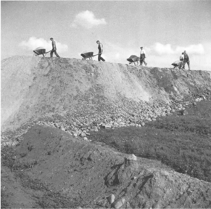
Kloakering af en del af industriarealet ved Ringvejen i slutningen af 1950'erne. Maskinerne havde ikke helt overtaget jordarbejdet; endnu kunne trillebør, skovl og menneskekraft blive brugt. Foto: Lokalhistorisk Arkiv for Viborg kommune.
