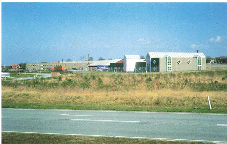
Caravell i Løgstrup er et stort, moderne fabrikskompleks. Foto: Caravell.
