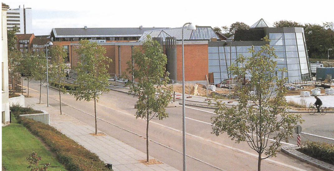
Viborgs nye svømmehal under opførelse i oktober 1997. Bygningen er stor efter byens skala, men den sammensatte facade, hvor massive murværkspartier brydes af spændstige glaspartier, gør arkitekturen oplevelsesrig og helheden overskuelig. Svømmehallen er tegnet af Nøhr & Sigsgaard, København. Foto: Ejvind Rasmussen og Anders Riis.
