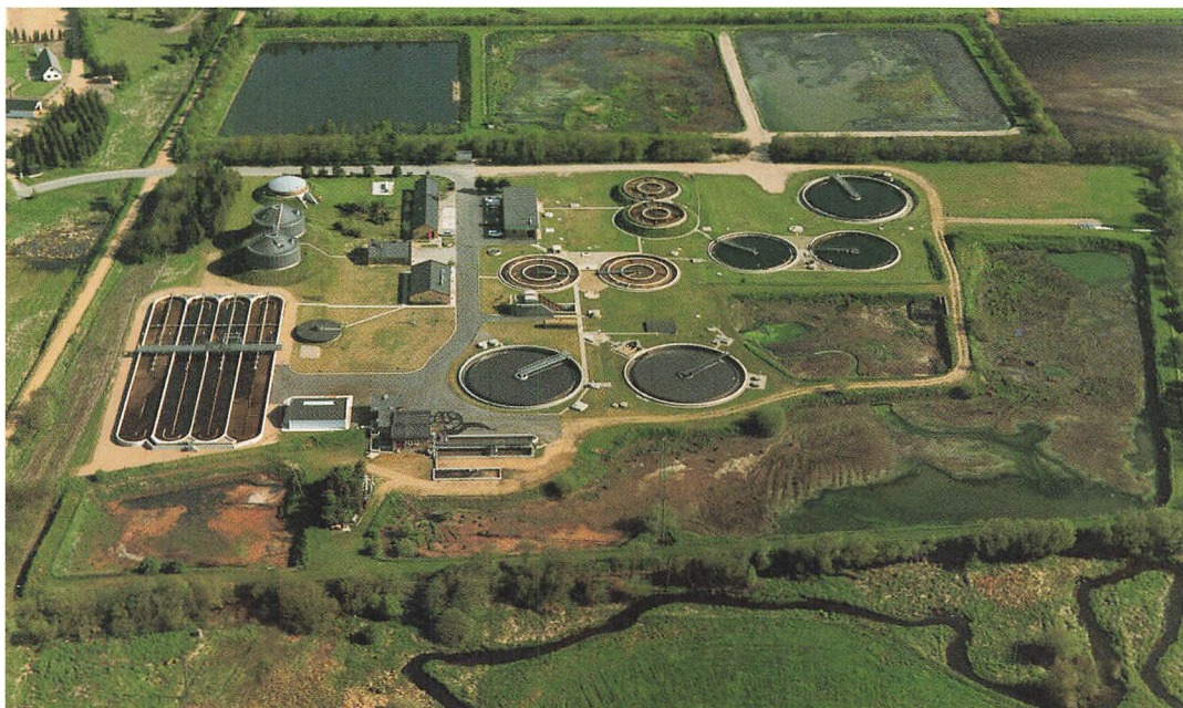
Viborg Centralrenseanlæg ved Bruunshåb, der renser spildevandet fra Viborg by og landsbyerne i den sydlige del af kommunen. Anlægget åbnede for biologiske rensning i 1971, i 1976 kom den mekaniske rensning til, i 1985 slambehandlingen og i 1993 den kemiske rensning til udskillelse af kvælstof og fosfor. I alt renses ca. 5 mill. m 3 i timen. Kommunens andet rensningsanlæg i Fiskbæk behandler spildevandet fra Løgstrup og de nordlige landsbyer. Foto: Viborg Centralrenseanlæg.
