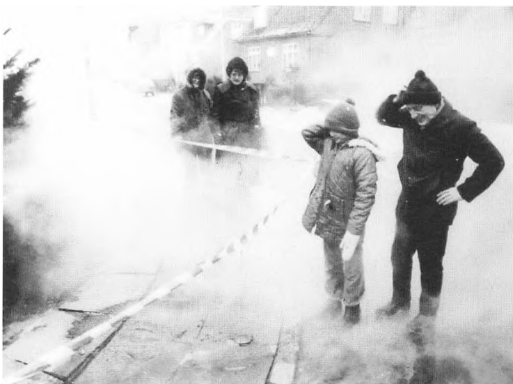
Vejr- og varmesituationen i Viborg i februar 1979. Bruddene på fjernvarmenettet i den kolde vinter blev forsidestof i aviserne landet over. Frøs man inde, kunne man til gengæld finde varme dampe udendørs. Foto: Lokalhistorisk Arkiv for Viborg kommune.
