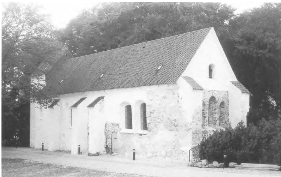
Asmild Kirke under restaurering. Her hvor de gamle kalklag er banket ned, afsløres det, at kirken har gennemlevet et utal af ombygninger. Foto: Hans Krongaard Kristensen 1979.
