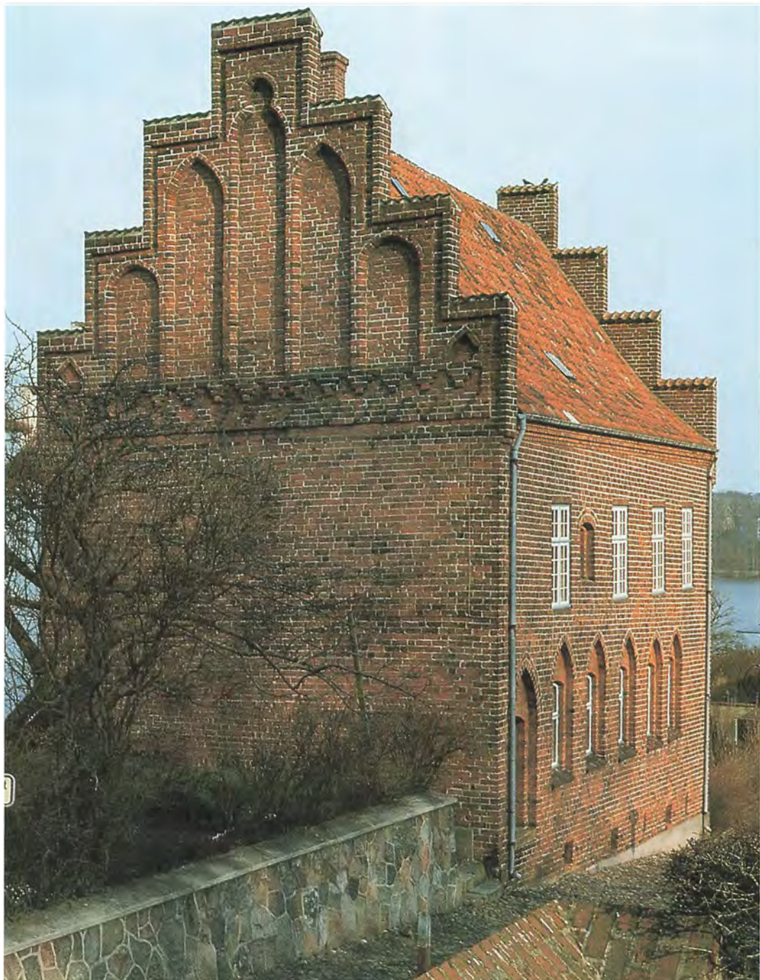
Domprovstegården set fra sydvest. Den prægtige vestgavl med sin meget varierede blændingsudsmykning er i dag ganske unik i det midtjyske, og forbillederne skal formentlig findes på Sjælland. Foto: Hans Krongaard Kristensen.
