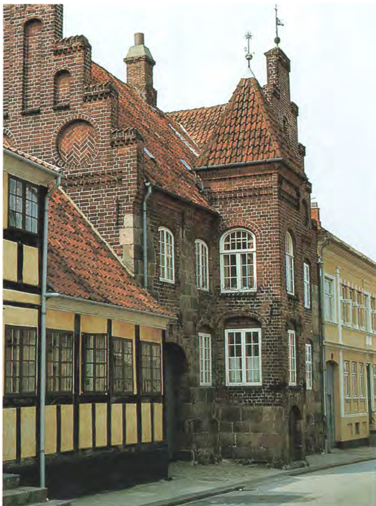
Karnapgården (matr.nr. 43) set fra Sct. Mogens Gade. Det store grundmurede hus, i to stokværk, blev rejst i 1640'erne på en middelalderlig kælder for byens læge dr.med. Christen Skytte. Huset blev omfattende restaureret i 1885. Huset i forgrunden (nr. 29) blev opført omkring 1600 som et bindingsværkshus i to etager med knægtbåret stokværksfremspring. Den øvre etage blev nedtaget i 1835. Foto: Hans Krongaard Kristensen.
