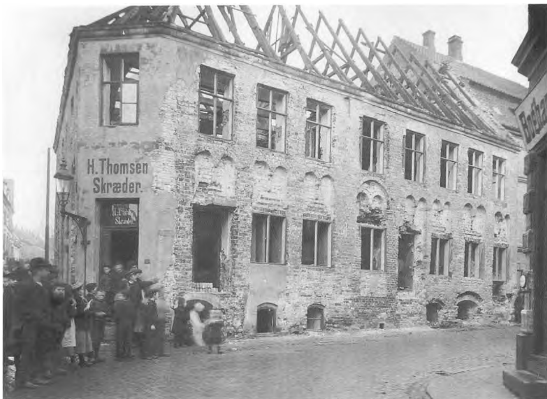
Det såkaldte Budolfi Kloster, som desværre af hensyn til den voksende biltrafik gennem Sct. Mathias Gade blev nedrevet i 1906-1907. Bygningen var et verdsligt beboelseshus fra tiden omkring 1500. Trods senere forandringer var huset ved nedrivningen et af de prægtigste middelalderminder i Viborg. Foto: Aage Munksgaard.
