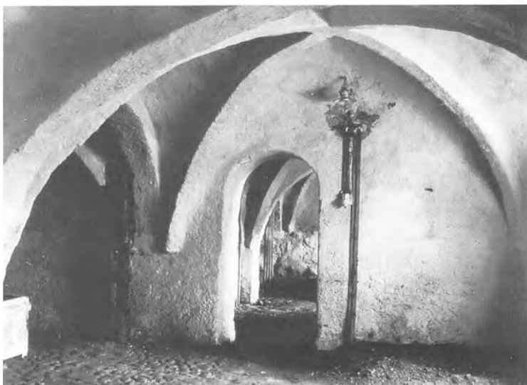
Kælderen under den middelalderlige kantorresidens. Gennem dørgennembygningen skimtes opbygningen med fire hvælv hvilende på en kvadratisk pille. Hovedhusets kælder består af tre sådanne identiske rum, som oprindeligt ikke var forbundet med hinanden, men hver for sig skulle nås fra gårdsiden. Foto: Hugo Matthiessen 1917.
