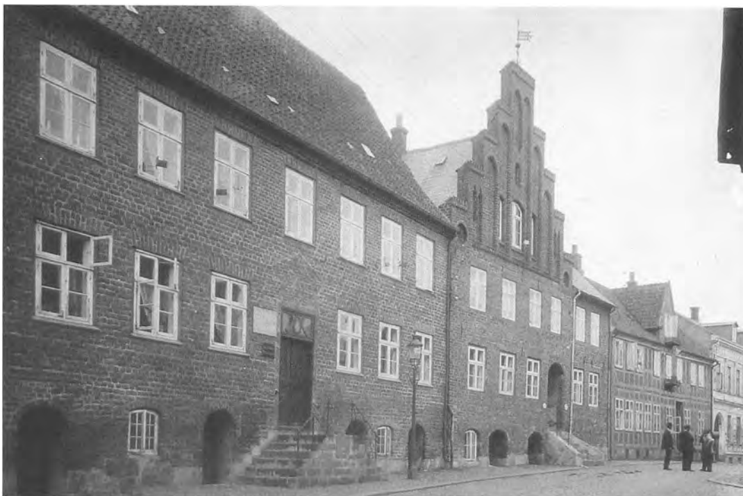
De middelalderlige huse Sct. Mogens Gade 7 og 9 i 1917. Huset nr. 7 blev ødelagt ved branden i 1726 og er fortsat præget af udformningen ved genopførelsen. Eksempelvis forsvandt nordfløjens gavl mod gaden. Også nr. 9 manglede i en lang periode i forrige århundrede gavltrekanen mod gaden. Den nuværende er fra 1884. Foto: Hugo Matthiessen.
