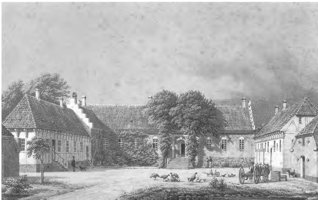
Tårupgård ved Hjarbæk fjords vestside er vistnok opført af kansler Niels Kaas o. 1580. Den solide hovedfløj er af munkesten på granitkvadre og kan stå som et eksempel på adelens nye byggeaktivitet i 1500-årene.
