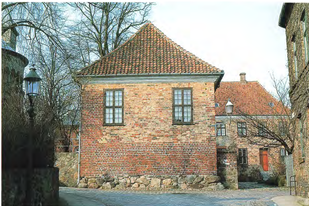
Sydgavlen på bispegårdens vestfløj. I bunden indgår murværk fra det lille senmiddelalderlige stenhus, som udgjorde herberget i kantorresidensen. Herover ses en reparation i renæssancen formentlig efter branden i 1567, mens murværkets øverste halvdel stammer fra Claus Stallknechts genopbygning efter branden i 1726. Foto: Hans Krongaard Kristensen.
