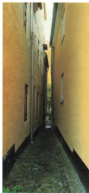
Tagdryp mellem Sct. Mogens Gade 7 og 9. Begge bygninger var gavlhuse, hvorfor langsiderne ikke kunne bygges sammen. Lig-nende tagdryp findes endnu et par steder i byen. Foto: Lars Guldager.
