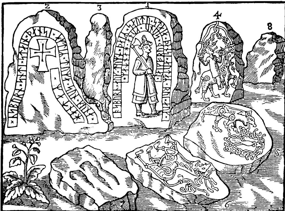
Hunnestad-monumentet, Skåne, fra omkring år 1000, sikret med hedenske symboler («det store dyr», skræmmemaske, jettekvinden Hyrrokkin, en øksebærende as (?) og det kristne kors. – Til dels ødelagt. Metalsnit fra Worms runeværk 1643.
