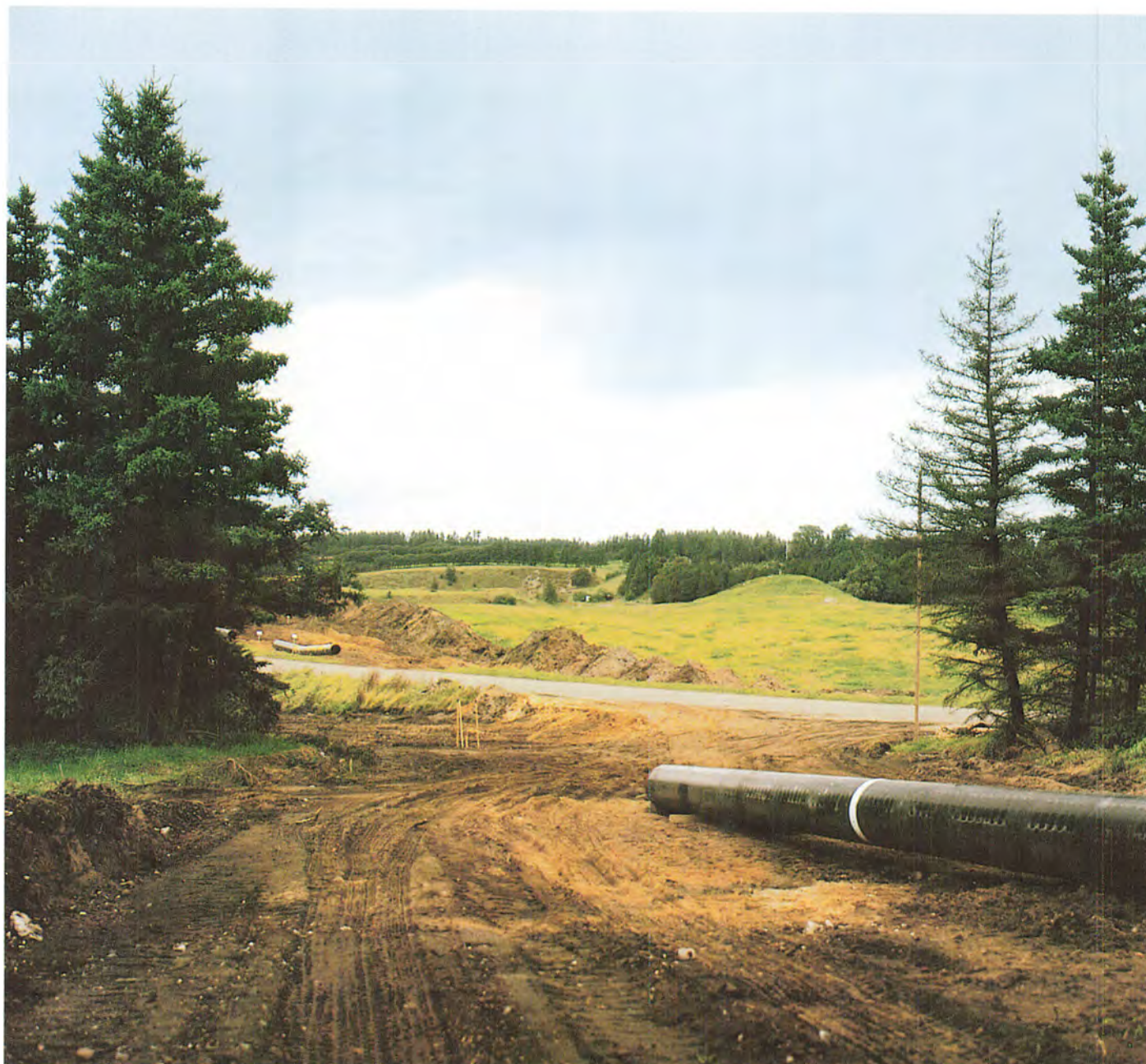
Fig. 7. Endelig er det arkæologiske arbejde overstået, og anlægsarbejdet gået i gang. Bo Hansen fot. 1985.
