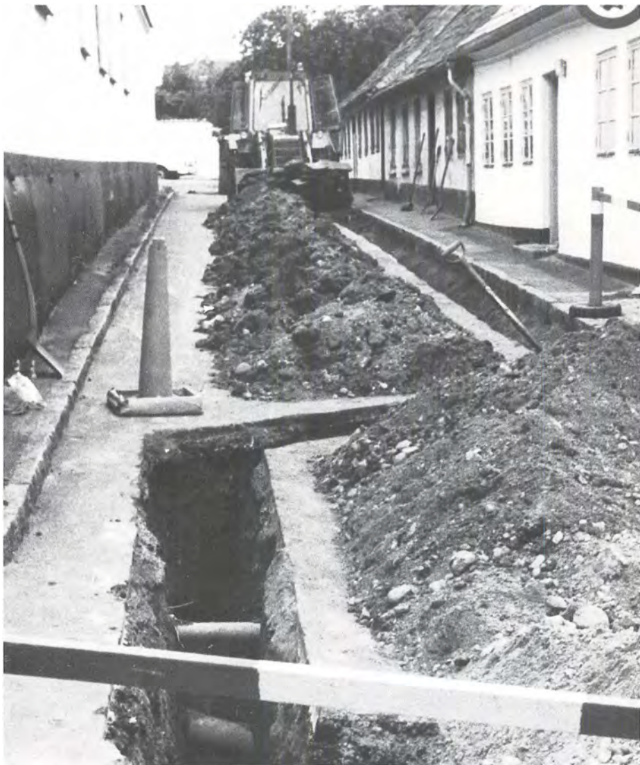
239:1. Holbæk. Nedlægning af naturgasledninger i Blindestræde. Der blev ikke gjort fund her, da der for nogle år siden var sket en gennemgravning i forbindelse med etablering af en hovedkloakledning. EA fot. 1984.
