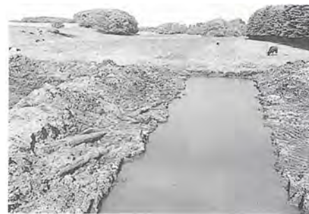
1511. Slevad Enge. Gennemgravet vandmølle ved Slevad Enge. Et offer på naturgassens vej. PEt fot. 1981.
