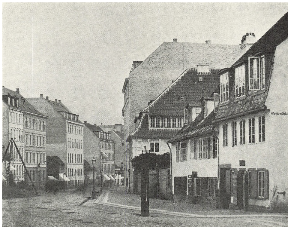
Fig. 5. Vesterbrogade set fra hjørnet af Øhlenschlægersgade mod øst. Apoteket ses til venstre i billedet med ørnefiguren over indgangen. I forgrunden åbne rendestene samt en vandpost. Privateje.
