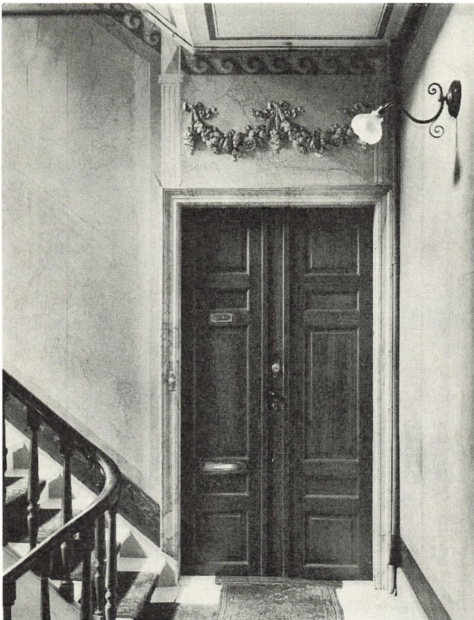
Fig. 1. Parti fra hovedtrappen med entrédøren på 1. sal. Døren er egetræsådet, navneskilt og beslag af blankpudset messing. Væggene er gulmarmorerede med grå „løbende hund“-frise. Fot. N. Elswing, 1967.
