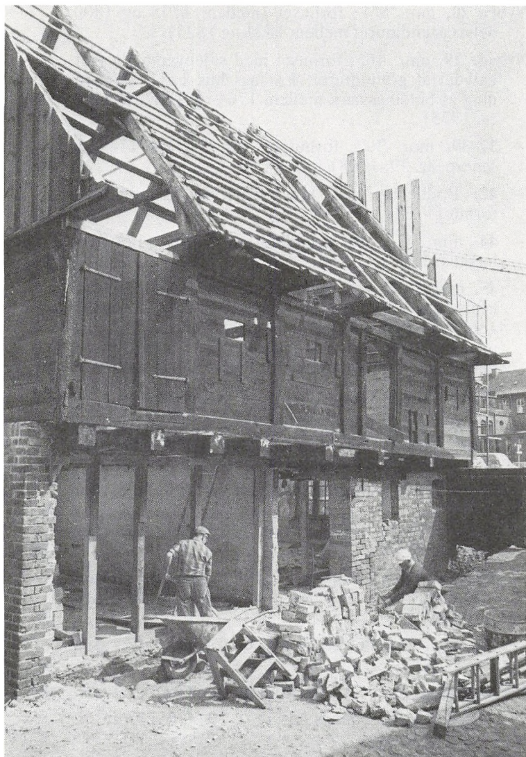
Åbenrå. Klinkbjerg 2. Bulhuset fotograferet under restaurering. Fot. Det særlige Bygningssyn 1978
