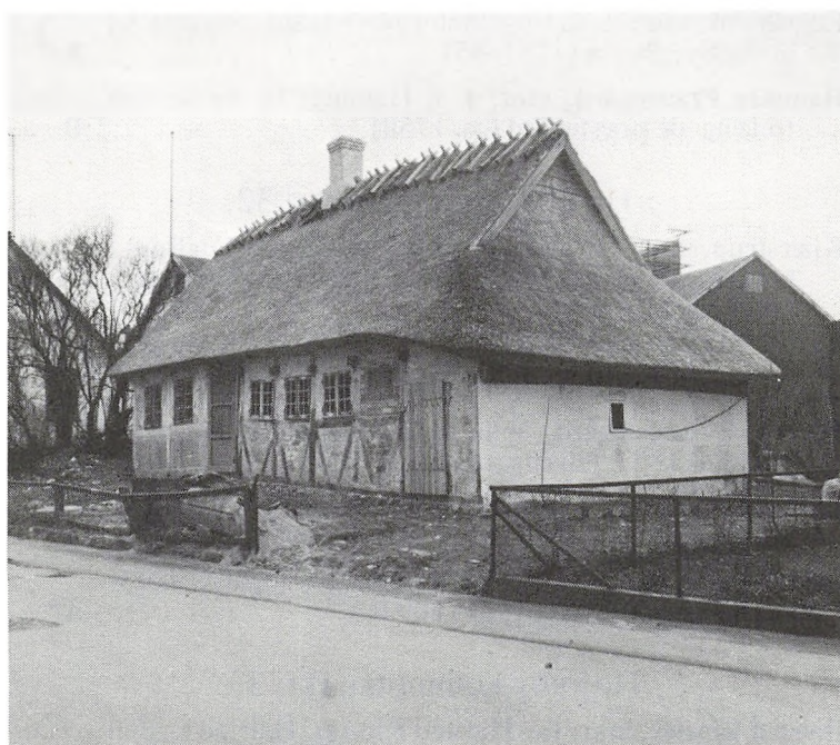
Fakse. Nørregade 9. Rasmus Svendsens skole under istandsættelse. Fot. Det særlige Bygningssyn 1977
