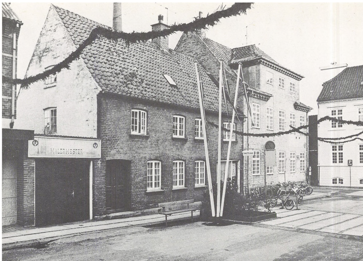
Østergade 41–43. Foto 1973. På grunden, svarende til Østergade 41–43, lå endnu ved århundredskiftet en ældre 2-etages bindingsværksbygning. I 1910 blev facaden i den vestlige del af forhuset omsat i grundmur. Den østlige del af bindingsværksbygningen blev nedrevet i 1916, og i stedet opførtes den nuværende 2-etages hjørnebygning efter tegning af professor Carl Petersen.
