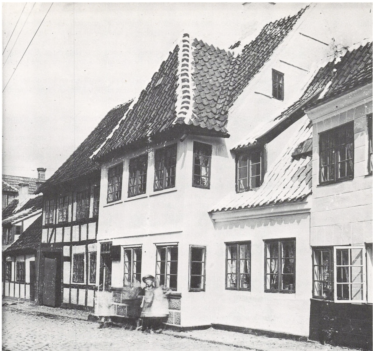
Klostergade 8–12. Foto 1908. Det høje forhus med den brede karnapudbygning er Klostergade 10, hvor der var indrettet synagoge i en periode indtil 1860. Det 2-etages bindingsværkshus med den halvåbne fløjport til venstre blev desværre nedrevet efter 1908 og efterlod et gabende hul i husrækken. Ødelæggelserne fortsatte da det laveste hus i rækken, nr. 14 (yderst til venstre), nedbrændte i 1971; det er dog heldigvis blevet genopført i grundmur og nænsomt tilpasset gadens profil.
