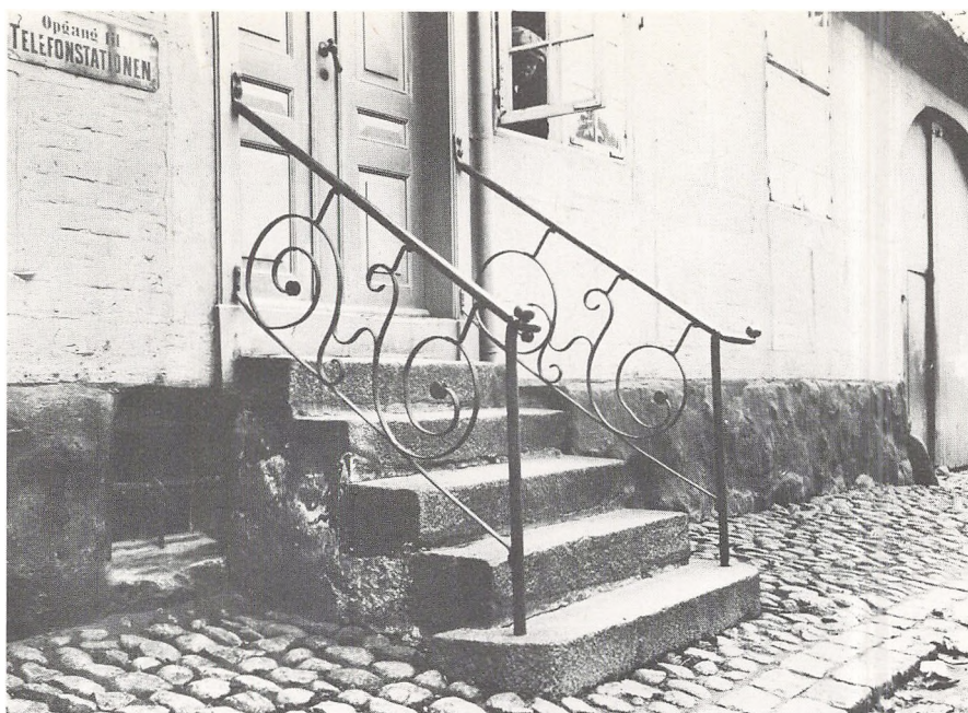
Hollegade 1. »Den gamle Gård«. Foto 1908. »Opgang til telefonstationen« står der at læse ved siden af den smukke fyldingsdør. Døren er sløjfet, smedjersngelænderet er ved en restaurering i 1932 flyttet til et andet sted i huset. Bygningen rummer i dag byens museum. Den høje granittrappe er enestående i Fåborg. Den fine pigstensbrolægning er fjernet og bindingsværkets tømmer er blevet optrukket. Små forandringer, der har forringet miljøet.
