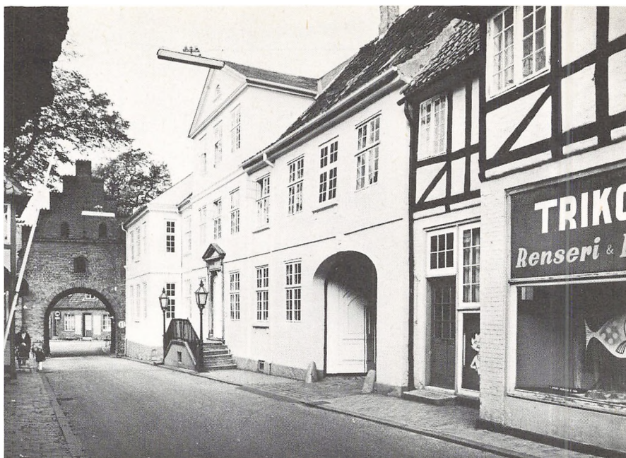
Vestergade 10. Foto 1971. Vestergade 10 er opført i slutningen af 1780'erne, muligvis med Hans Lang den Ældre som bygmester. Den enkle facades fornemme præg vidner om en talentfuld bygmester, og den sparsomme anvendelse af facadedekoration og portens à la grecque bort leder tanken hen på Harsdorffs arkitektur.
