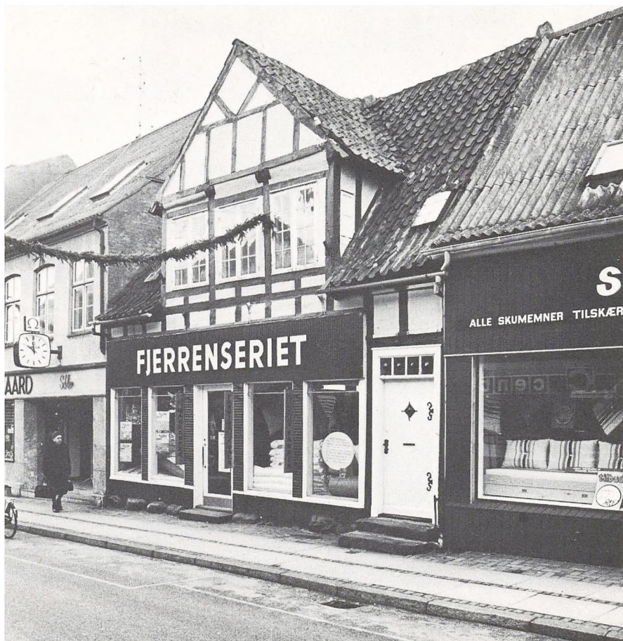
Østergade 38. Foto 1973. Dette nye fotografi af Østergade 38 viser, hvorledes man kan mishandle et fint gammelt hus. Skorstenen er blevet fjernet, døren er blevet udskiftet, men mest ødelæggende er dog butikken med overdreven skiltning, facadebeklædning og store vinduer.
