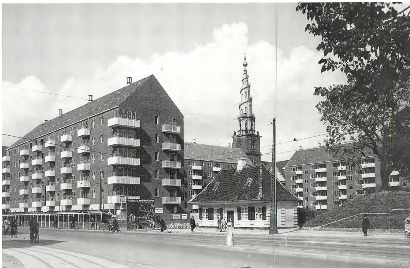
Bebyggelsen »Ved Volden« med den tilbagerykkede gamle vagt i forgrunden og Vor Frelsers Kirke i baggrunden. Fotografi fra 1938 med tydelig markering af den ældste profil i den senere forhøjede Vold. (Bo Bransen)
