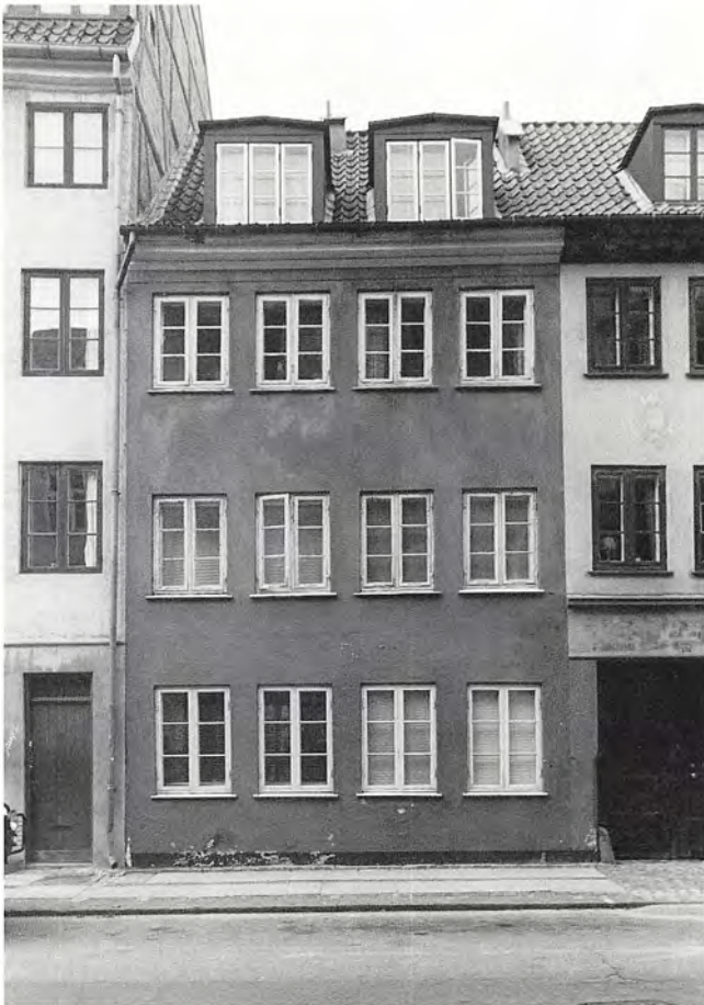
Dronningensgade 25, vestre forhus
