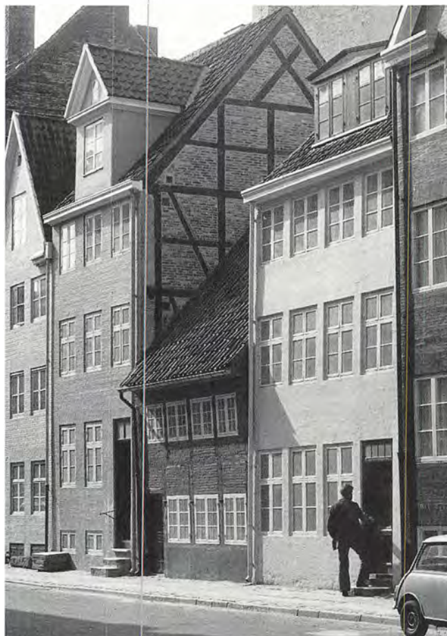
De kondemnerede huse Sankt Annægade 16, 14 og 12 efter gennemførelsen af »bevarende sanering« 1975. (HL fot.)
