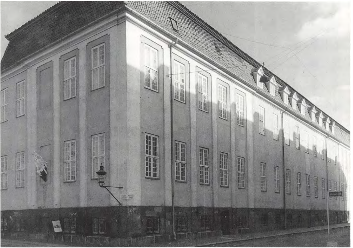
Overgaden oven Vandet 58 - 64 · Sidebygning til Bådsmadsstræde
