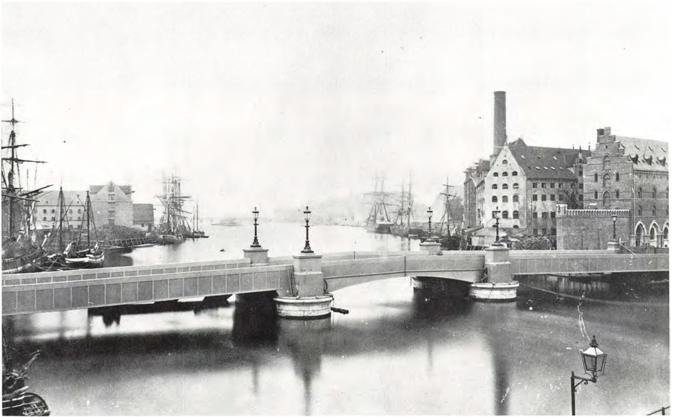
Wains jernbro fra 1866 vakte international opmærksomhed, da den blev bygget. (Bo Bramsen)
