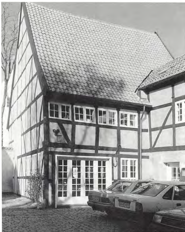
Strandgade 28 - 30 · Baghuset til Wildersgade 41
