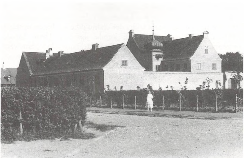
Det nye Ting- og Arresthus i Ålborg, hvor arkivlokalets døre og vægge var beton, døren af jern. Kgl. Biblioteks billedsamling, foto Tage Ludvigsen.
