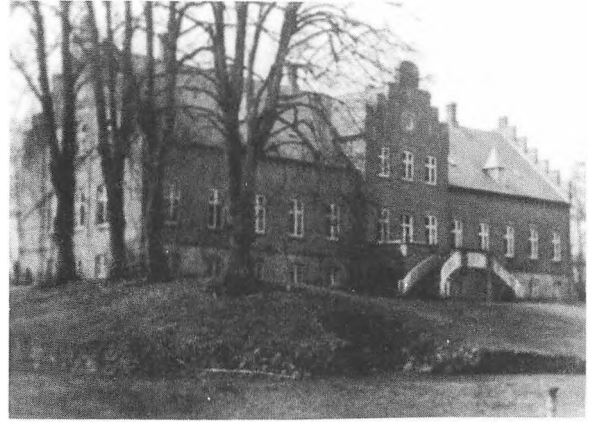
III.A.7. Hovedbygningen på Høegholm
