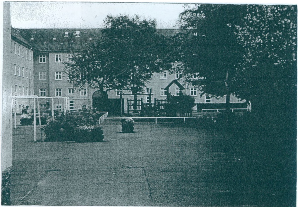
Bogfinkevej 5-23 & Rørsangervej 61-73 opført i 1923 af kommunen, og nu privat andelsboligforening. Velholdt gårdhaveanlæg. Mod gade er der også forhaver.
