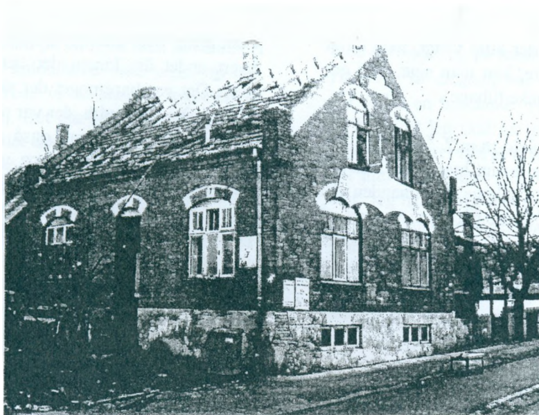
Ny Jægerkro under nedrivning i 1970'erne
