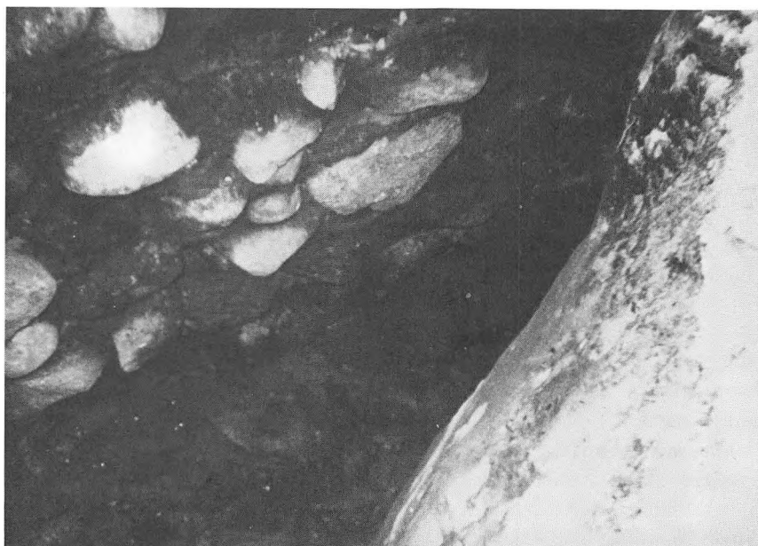
Stenpikning uden for kældrens nordre hjørne.
