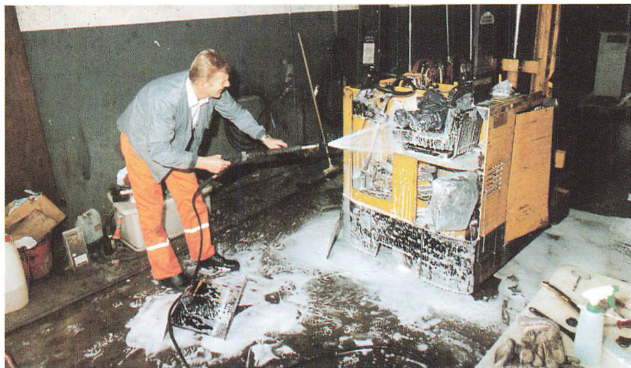
Renoveringsopgave efter større virksomhedsbrand.
