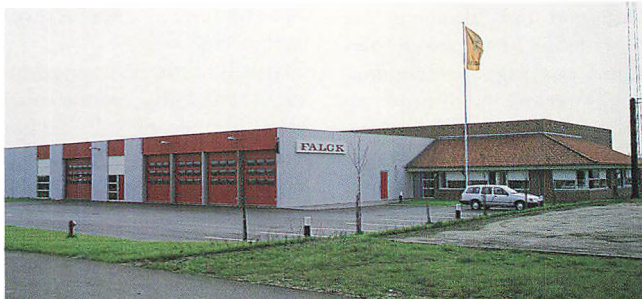
Den ny station i Bjerringbro, som blev indviet i 1987.
