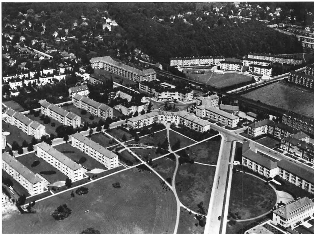
Luftfoto af Virum Torv med omkringliggende bygninger på Frederiksdalsvej og Grønnevej. Lyngby-Taarbæk Stadsarkiv, 1951.
