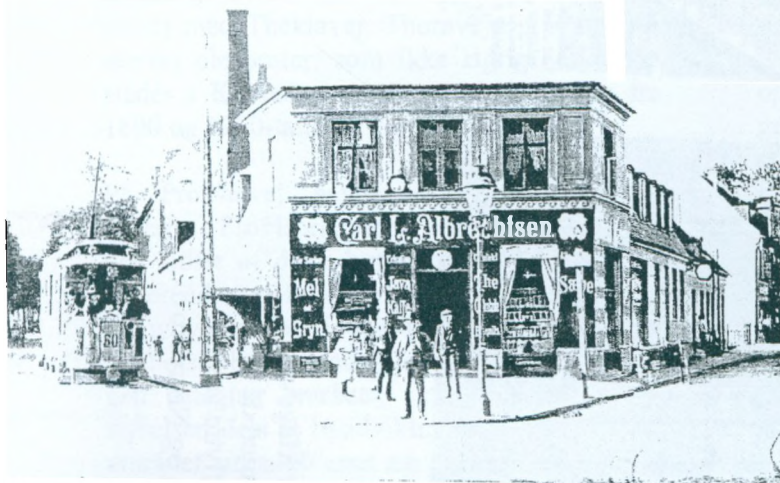
☛ Carl L. Albrechten år 1900 til 1930'erne Den 2 bygning på hjørnet af Frederiksborgvej.
