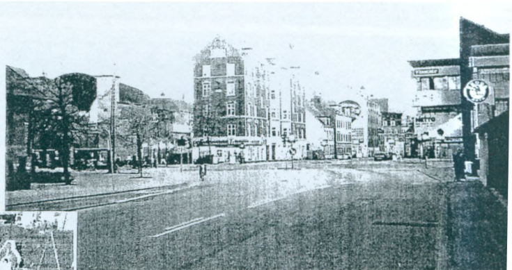
"Nordvestporten" fra/til København/Nørrebro i 1950'erne og 1999. Bemærk hjørnebygningen Frederikssundsvej og Nordre Fasanvej.
