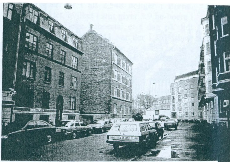
Brofogedvej ved Frederiksborgvej med typisk byggeri fra omkring 1900 med uheldig boligbyggeri fra 1960'erne
