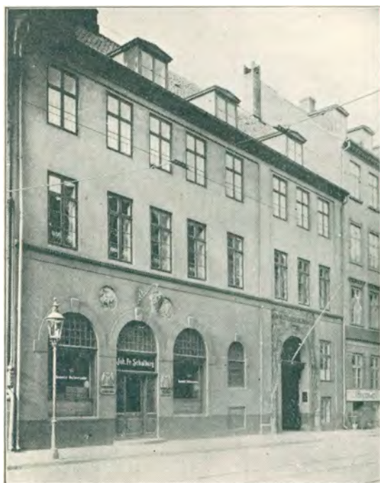
Johan Fr. Schalburg, Facaden mod Stormgade.
