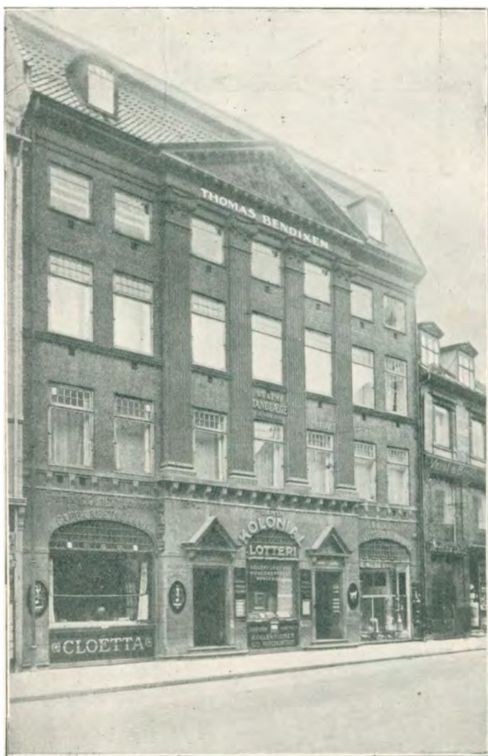
Ejendommen paa Amager Torv, hvori Firmaet Thomas Bendixen har Fabrik og Kontorer.
