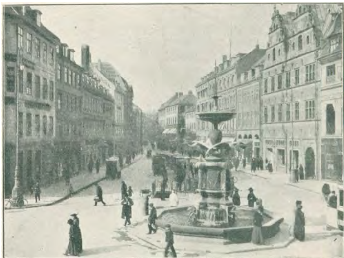
Parli fra Amagertorv med Storkespringvandet Fot. Christensen, Amagertorv.
