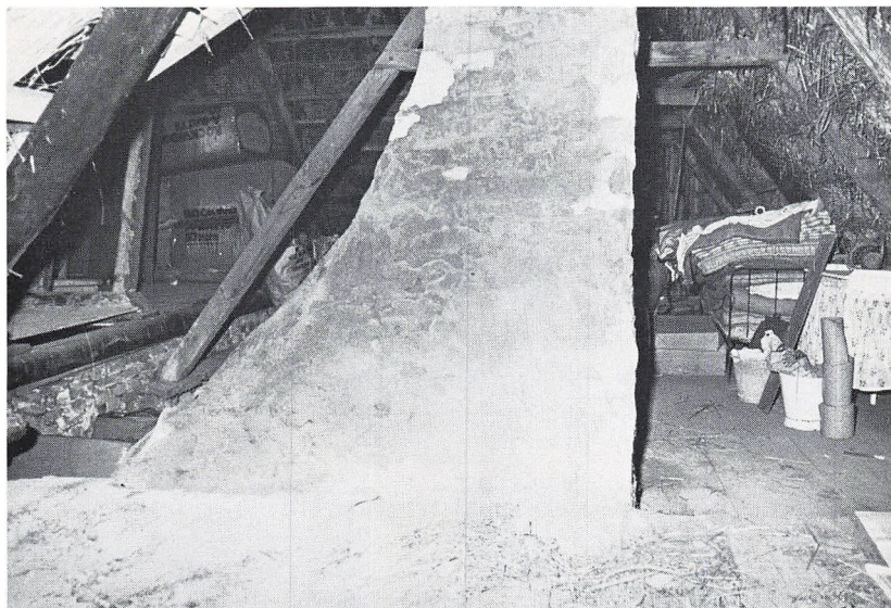
Fig. 9. Skorstenspijen på ejendommen Fabersvej 10 set fra loftet. Foto: Julius Jørgensen.
