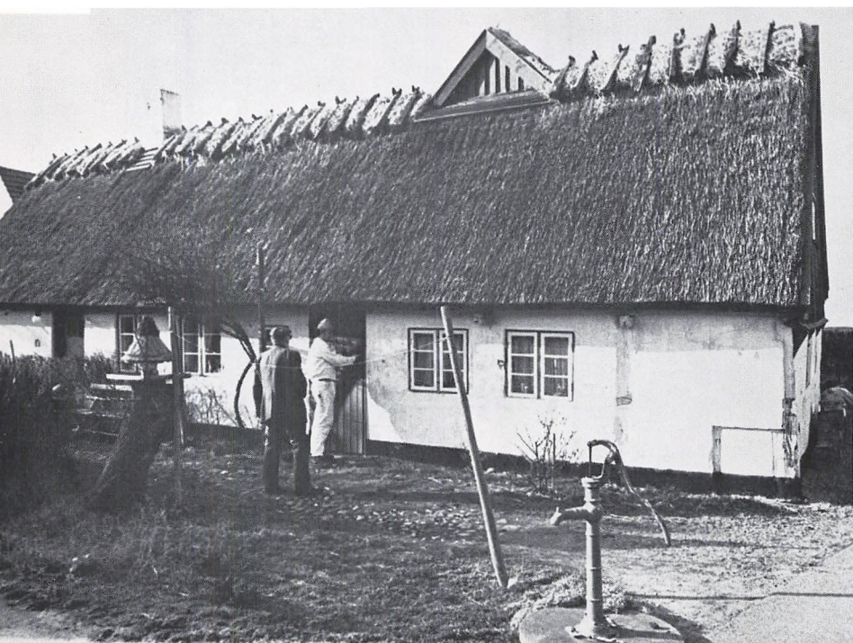
Fig. 6. Sydsiden af ejendommen Fabersvej 10 med halvdør ind til forstuen. Foto: Julius Jørgensen.
