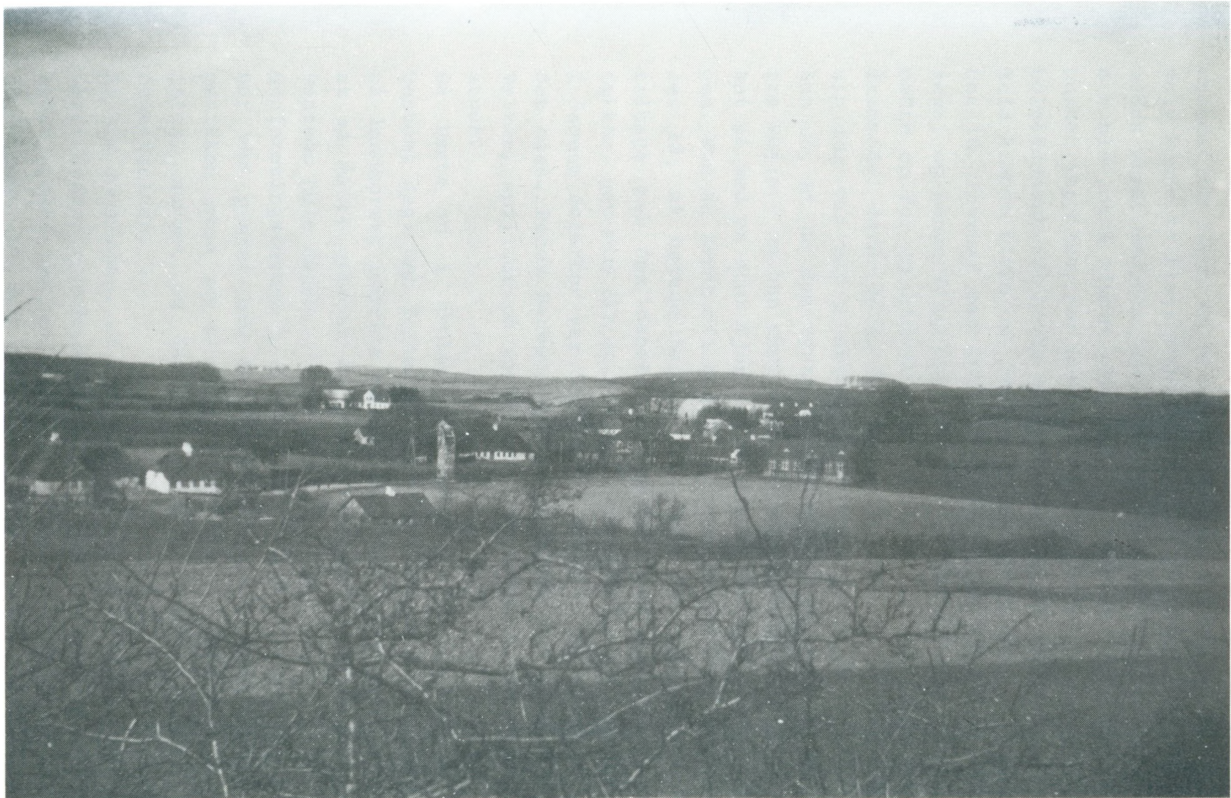
Udsigt fra Jydeberg ned over Skovbøl. Bag transformatorstårnet Jørgen Hansens hus, der brændte 24. juni 1935.
