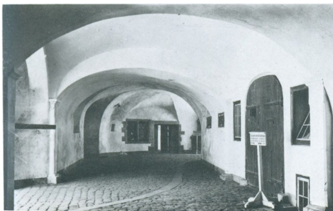
En S-snoet vej fører fra broen over den vandfyldte voldgrav gennem kasematten frem til Mørkeport.
