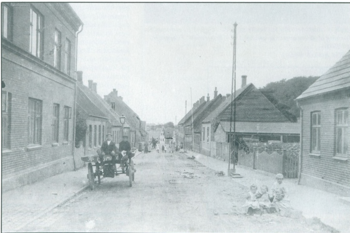
Brandtsgade set fra Vordingborgvej mod Havnen i ca. 1915. Man ser at gaden også oprindeligt var en blanding af een- og toetagers huse. (NÆM TP: 72,78).
