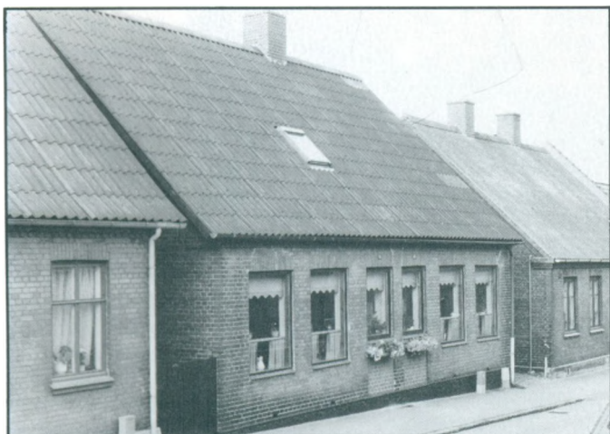
Brandtsgade 14. Typisk arbejderbolig til 2 familier. Bygningen er opført i begyndelsen af dette århundrede i rød blank mur. Tilsvarende arbejderhuse ligger stadig på Rejstrupvej og f.eks. på Kildemarksvej. Fotograferet i 1986. (NÆM B: 86:09:03:05).
