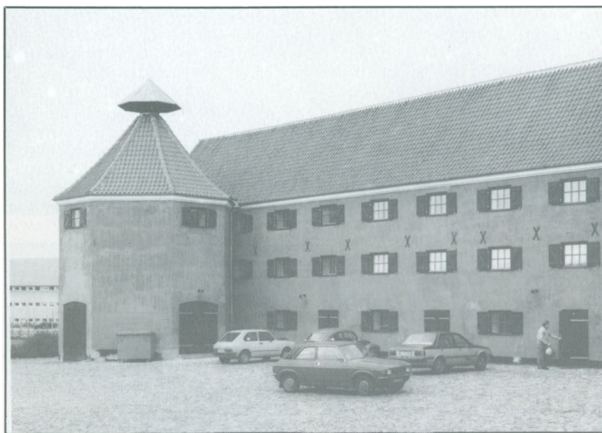
Magasinbygningen i Møllegade, set fra gården til Brogade 2. Det ottekantede tårn blev oprindeligt som korn tørreovn »... af engelsk konstruktion med jernbjælker og flisegulv«. Fotograferet 1986. (NÆM 86:11:01:11).
