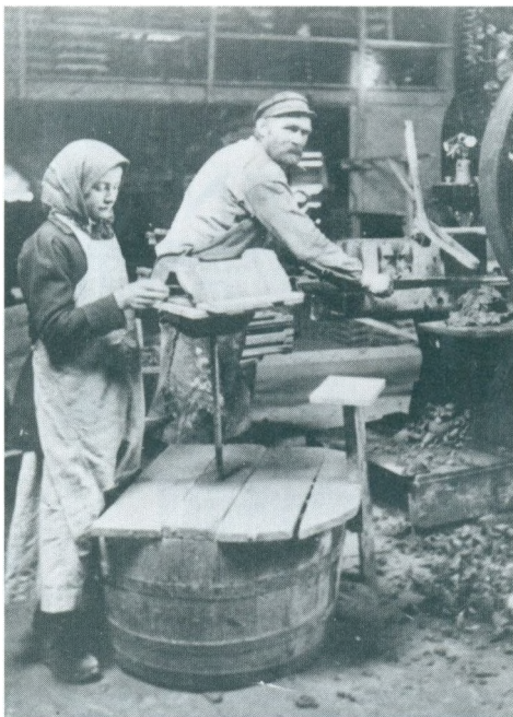
Ester Burkqvist vid formen där man pressade taktegel.
