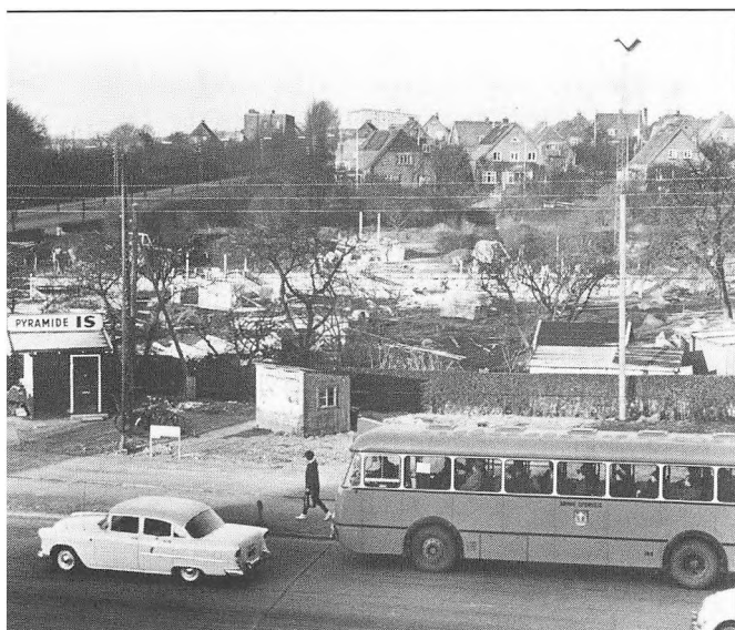
Hjørnet af Viborgvej og Vestre Ringgade ved byggeriets start i 1963.
