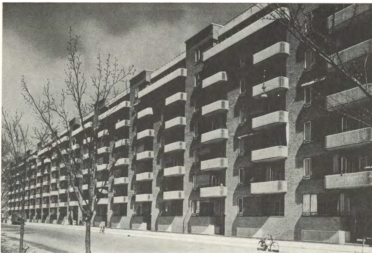
Kay Fisker og C. F. Møller: Vestersøhus, Vestersøgade, 1935–39. Karnapper og indbyggede altaner. Allanbrystninger af smedjejerns-balustre.
