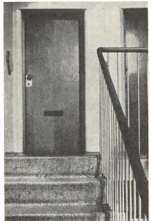
Trappegang i en moderne boligbebyggelse. Dørene er næsten altid af møbelplade, som oftest umalede for at lade træets struktur fremtræde, ligesom tilfældet er med møblerne. Som trapperækværk benyttes i reglen den her viste type: lakerede eller parkererede metalrør med træhåndliste. Trappen er af beton med terrazzobelegning, enten støbt på stedet eller opstillet af færdigstøbte standardtrin.
