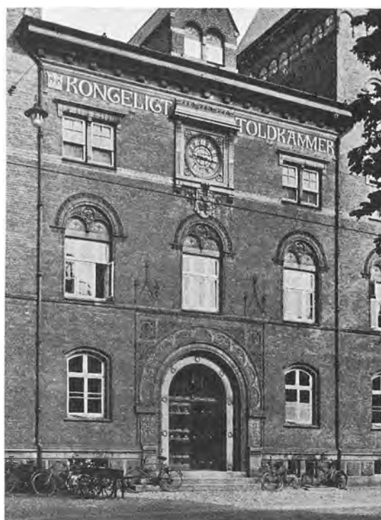
Jens Vilh. Petersen: Toldkammerbygning på Stationsvej i Odense, 1899. Sml. Nyrops Rådhus.
