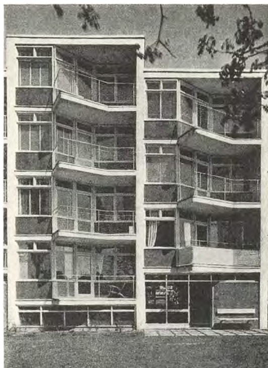
Mogens Jacobsen og Alex Poulsen: Svendebjergshus, Hvidovrevej, 1951. Muligheden for efter loven at bygge til en højde af 3½ etage kompenseredes ved afvekslende at bygge i 3 og 4 fulde etager, derfor springet fra blok til blok. Udnyttelsen af det tilladte etageareal tvang til den usædvanlig store husdybde og førte derved ind på anbringelsen af trappen midt i bygningen.
