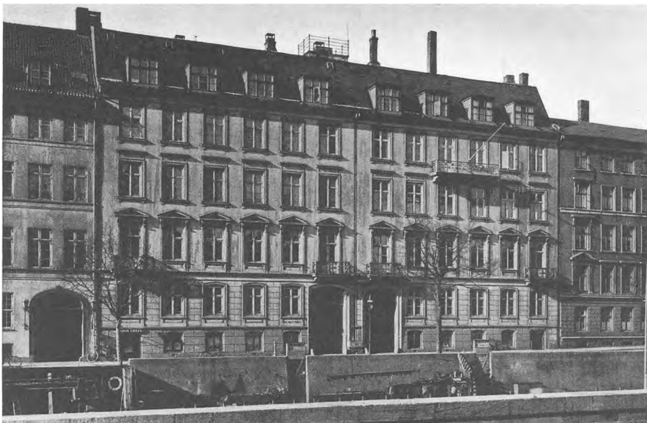
H.C. Stilling: Façaden til Frederiksholms Kanal 16-18, approberet 1850, opført 1851-52. Egentlig en ældre ejendom, der blev forhøjet to etager og adskilt ved en brandmur i midten.
