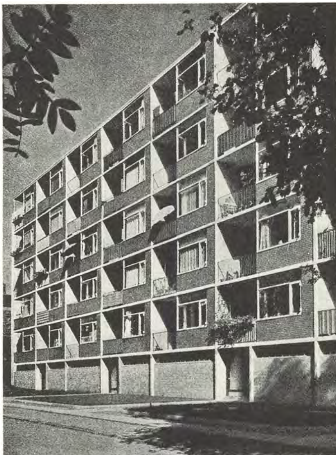
Hubert Poulsen: Hjørnet af Trunnevangen og Jensløvs-Tuørvej, Charlottenlund, 1939. Betonkonstruktion med udfyldning af mursten. Underste etage er kælder. Konstrueret efter ingeniør Ernst Ishøys princip med bærende tværvægge (se s. 309).
