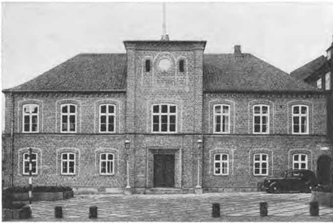
N. S. Nebelong: Holstebro Rådhus, 1846. Som helhed af røde mursten i forskellige sorteringer (d.v.s. lysere og mørkere) blandet mellem hinanden. Over granitsokkelen er sat et rulskifte, (d.v.s. lodret stillede sten). De flade bånd i murværket og taggesimsen er af gule mursten og der er brugt gul mørtel til fugning (sml. Hetsch's Katholsk Kirke, s. 12). Det fremspringende midtparti og sidepartierne indrammes af liséner. Taget er rødt tegltag. Helvalme er også et senklassicistisk træk.
