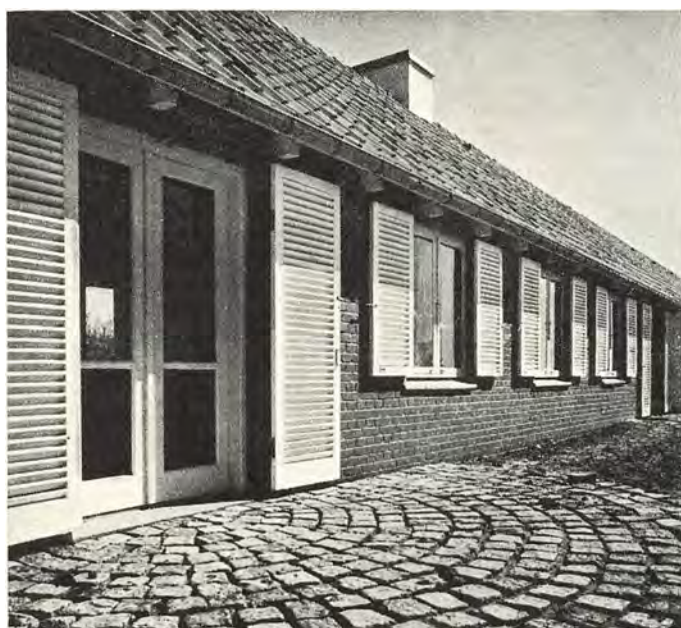
J. Søtrup Jensen: Statslånshus i Esbjerg, 1946. 1:300. Huset er opført med forskudte etager, den højere del med soveværelser over den høje kælder, den lavere del uden kælder med opholdsstuen i niveau med haven. Denne type med forskudte etager er blevet meget almindelig i de senere år, fordi den isolerer soveværelserne og alligevel muliggør at få opholdsstuen i forbindelse med haven.
