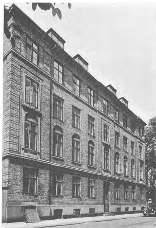
H. C. Stilling: Schönbergsgade 15, 1857. Som vandret og lodret proportionsenhed kan regnes en risalit-bredde. Murværket viser megen stoffig finhed i anvendelsen af røde skifter i den gule mur. Særlig pragtfuld er gesimsen. Opmåling 1:300.
