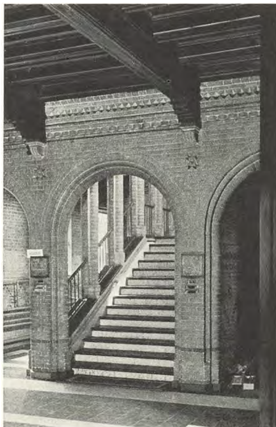
Universitetsbibliotekets forhal, mursten og bjælkeloft. Tilvenstre hvælving over forhallen, efter italiensk forbillede.
