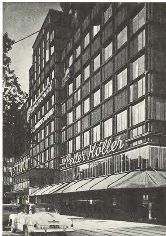
Ole Falkentorp og Poul Baumann: Kontorbygningen Vesterport, 1930-32. Stålskeletkonstruktion, udvendigt beklædt med kobber. Overgangsform mellem nyklassicisme og funktionalisme.
