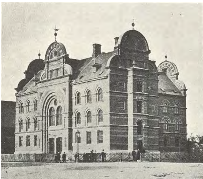
C. Knudsen: Ahornsgade 16, 1885–86. »De små hjørnetårne såvel som gavlens topforsirning agtes udført af støbt zink med indvendig jernafstivning« (fra ansøgningen til bygningsmyndighederne).
