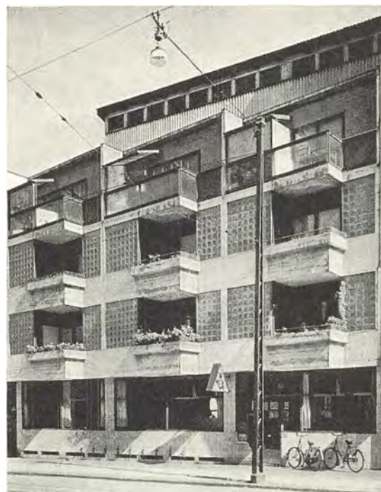
Edvard Thomsen: H.C. Ørstedesvej 54, 1939. Betonhus med bærende tværvægge. Karnap-variant til gaden, svalegange til gård. Fasadens savtaktede form, med tilbagespring foroven og ved balkonerne, skyldes grundens skæve form. Karnapperne af indmuringsglasblokke.
