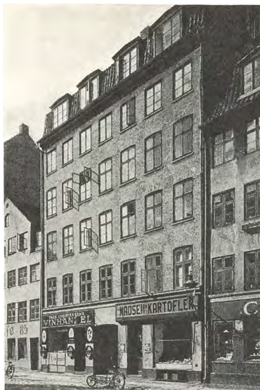
Adelgade 87, 1846. Gul, upudset mur, fladbuede vinduesafslutninger, en »tektionisk« (håndværksmæssig-konstruktiv) murstensgesims med nedhængende tapper er et senklassicistisk træk. Mansardtaget er nyt.
