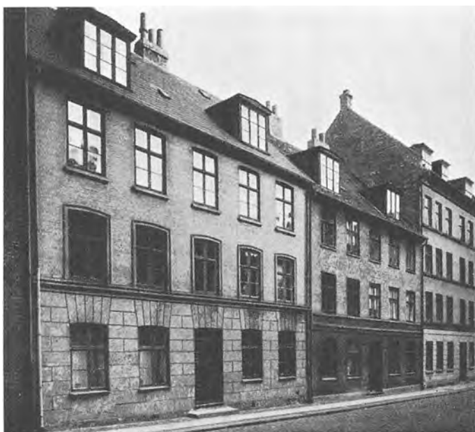
Gernersgade 1, 1856. Båndgesimsernes anbringelse udfor etageadskillelsen tillader de små brystningsblændinger under vinduerne, der styrker façadens relief. Trappen er ført op bag gadesidens vinduer længst tilhøjre. I gesimsen høje kragsten. Kvaderfugning.
