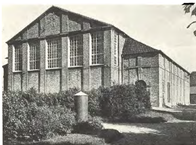
Ivar Bentsen: Svininge Elektricitetsværk, 1913. Maskinhallen.
