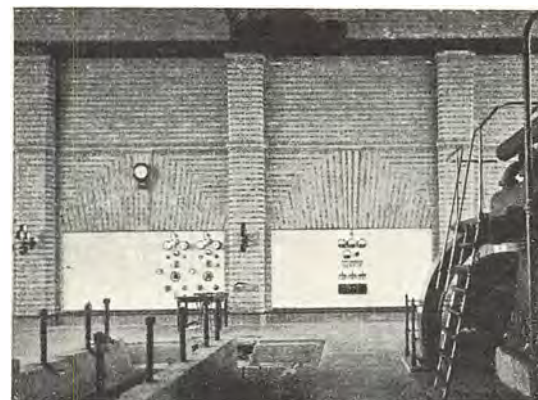
Ivar Bentsen: Svininge Elektricitetsværk, 1913. Administrationsbygning og maskinhal. Denne sidstes store, stråleformede stik mellem lisenerne viser interessen for murstensbehandling, sml. Jensen Klints Brand- og Politistation, s. 267.
