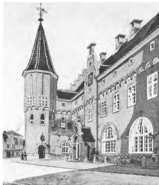
Hack Kampmann: Post- og Telegrafbygning i Ålborg, 1908-10. Akvarel af Kampmann fra 1912.
