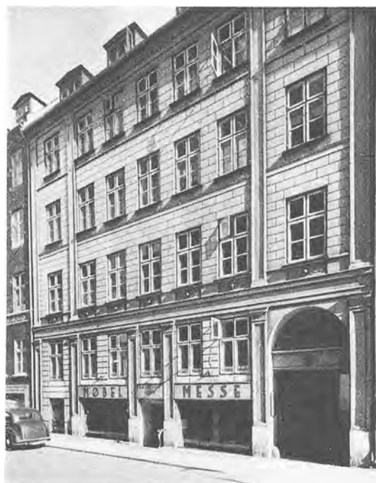
Skindergade 23 (façaden fra 1856). Pilastrene har ganske mistet deres konstruktive karakter og fremtræder kun som en detalje i relieffet, sml. deres udsmykning med et tilbagespringende, fyldningslignende midtfelt.
