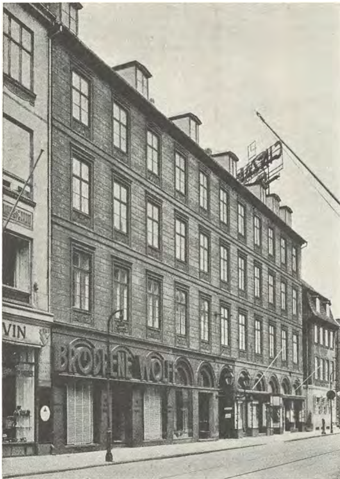
H. Chr. Tybjerg: Bredgade 4, 1853-54. Façaden er pudset og oliemalet, lineært kvaderfuget, med tynde, i de to øverste etager dobbelte båndgesimser, spinkle, ganske svagt skrånende vinduesindfatninger, der står på båndene, aftagende vindueshøjder opefter, figurornamenter af gips under vinduerne, skifertag. Tagrenden var oprindelig carnisrende. Afvekslingen mellem højere og lavere skifter i kvaderfugningen er ligeledes et Schinkelsk træk. Slægtskabet med Feilners hus i Berlin er tydeligt. Façadens spinkle, lette rytme og formgivning har et jævnyrdigt udtryk i arbejds-tegnings tegnemåde.
