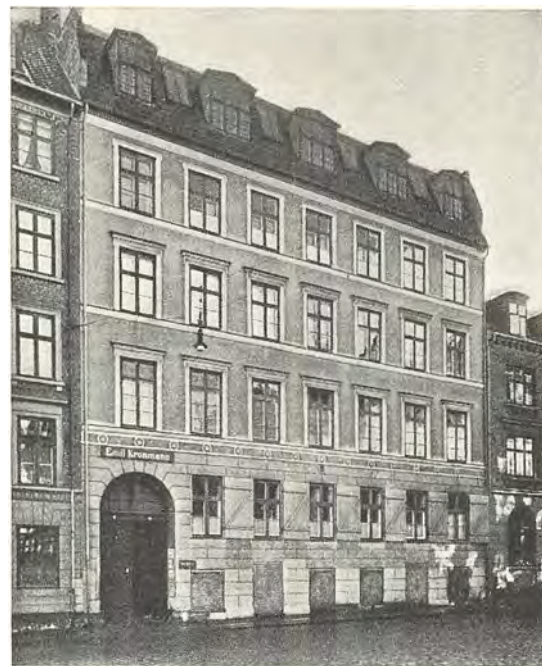
Hauserplads 10, façade fra 1848, mansardtaget senere. Façaden er pudset og vandret afstribet ved båndgesimser, hvorpå de Schinkelske, let skrånende og med små »ører« forsynede vinduesindfatninger går ned. Også det med runde feller smykkede dobbeltbånd over stue-etagens kvaderfugning er et karakteristisk træk.
