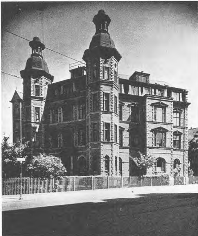
F. Meldahl: Hovedbygningen på Stubbarp ved Arildsleje på Kul-len; omkr. 1851-52. De fem dele af forsiden er hver 10 alen. Den øverste del af tårnet er det halve af den nederste del over kælderen. Tårnets gesims flugter med tagryggen bagved.
