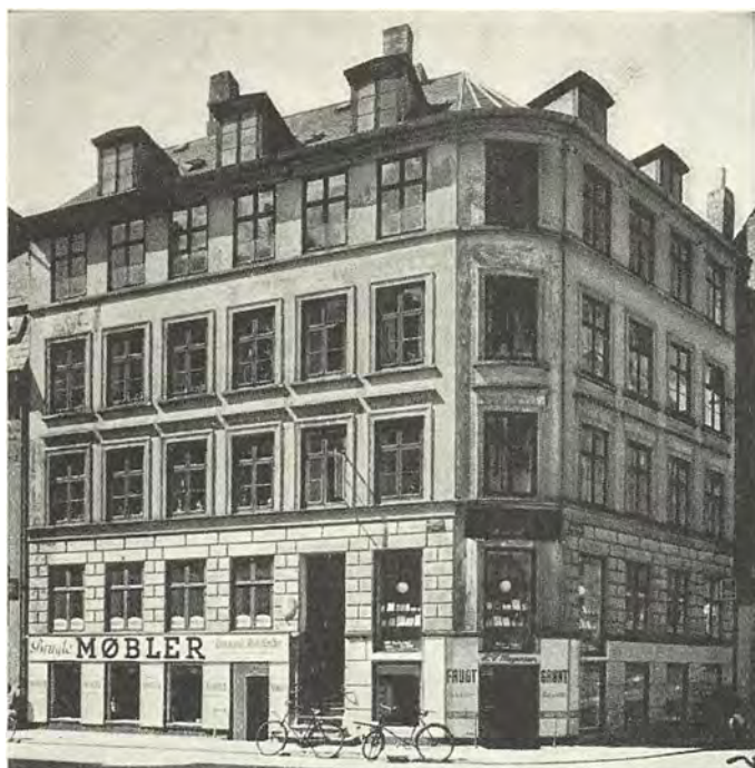
H. Chr. Tybjerg: Hjørneejendommen Peder Hvitfeldtsstræde 17 1855-56, plan s. 75, vindue og dør s. 98 og s. 100. Eksempel på en façade med første og anden sal samlet til et parti. For at opnå balance er stueetagens kvaderfugning tilsvarende kraftig.
