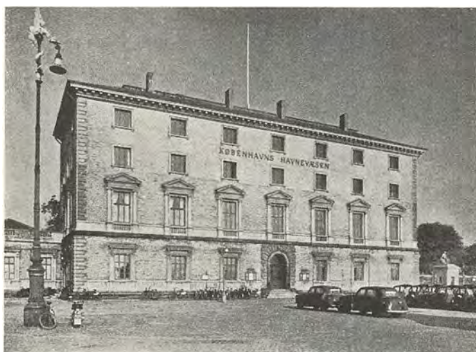
Vilh. Dahlerup og Fr. Böttger: Havnadministrationsbygningen ved Nordre Toldbod, 1868.
