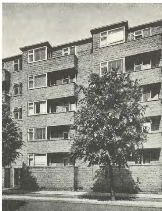
Palle Suenson og Thorvald Dreyer: »Treledet«, Finsensvej 61–71, 1930–31. Karnapper og udvendige altaner. Murede altanbrystninger.
