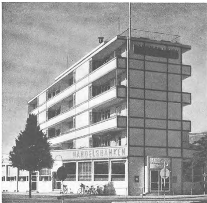
Frits Schlegel: Godthåbsvej 229, 1936. Den glatte, vinduesløse nordside mod Godthåbsvej, der kun får arkitektonisk karakter ved den konstruktive inddeling, fremhæver bankens indgang og de store skillebogstaver foroven.
