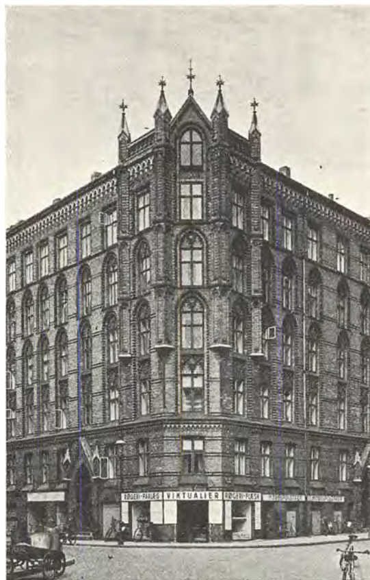
C. Knudsen: Ahornsgade 16, 1885–86. »De små hjørnetårne såvel som gavlens topforsirning agtes udført af støbt zink med indvendig jernafstivning« (fra ansøgningen til bygningsmyndighederne).
