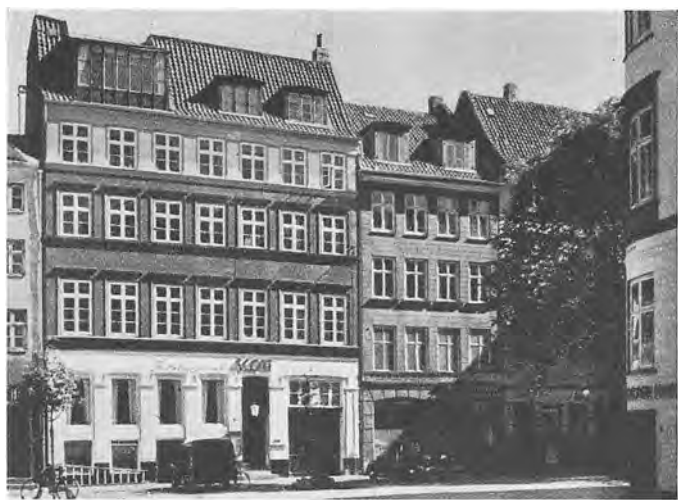
Gråbrødretorv 15, 1851-52, og Gråbrødretorv 17 (lig Valkendorfs-gade 32), 1856-57. Nr. 15 har de små Schinkelske pilastre i øverste etage og det monstre 60-graders tag, her for en gangs skyld behængt med legl. Nr. 17 er en af de sidste ejendomme med båndfrise over stue-etagen.
