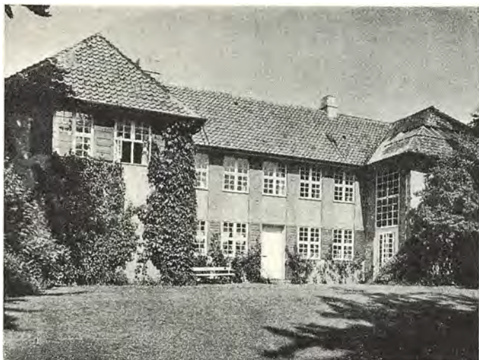
Ivar Bentsen: Billedhuggeren Kai Nielsens hus, Ørnekulvej 14, Ordrup, 1914. Opført af Bentsens yndlingsmateriale, den flammende sten. Taget er røde tegl, med stort udhæng og en enkelt, hvidmalet brædeforskalning under. Vinduerne er hvide med grønne skodder. Faginddelingens fasthed fremhæves ved lisener mellem midtpartiets vinduer. Fløjen tilhøjre er atelier. Hegnet er et lavt kampstensdige, der runder sig blødt om vejens hjørne. I den ene side, mod Ørnekulvej, afløses det af en mur af flammende sten, der skærmer mod indlik i største delen af haven.
