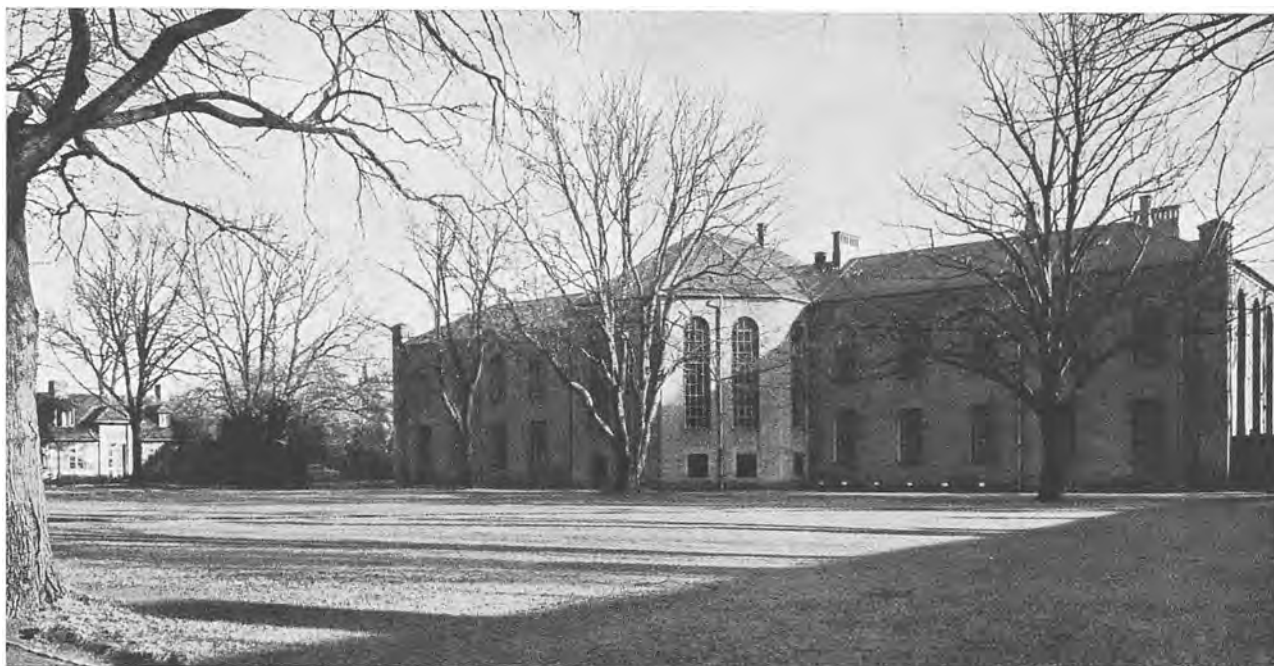
G. Bindesbøll: Veteriner- og Landbohøjskolen. Gårdside af hovedbygning samt staldbygningen.
