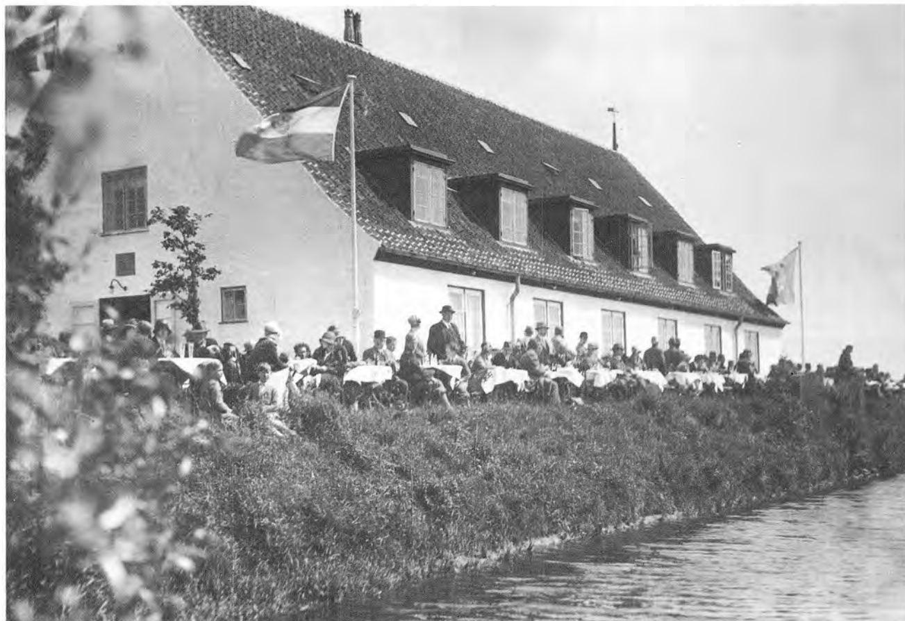
Sommerdag ved Krudthuset
