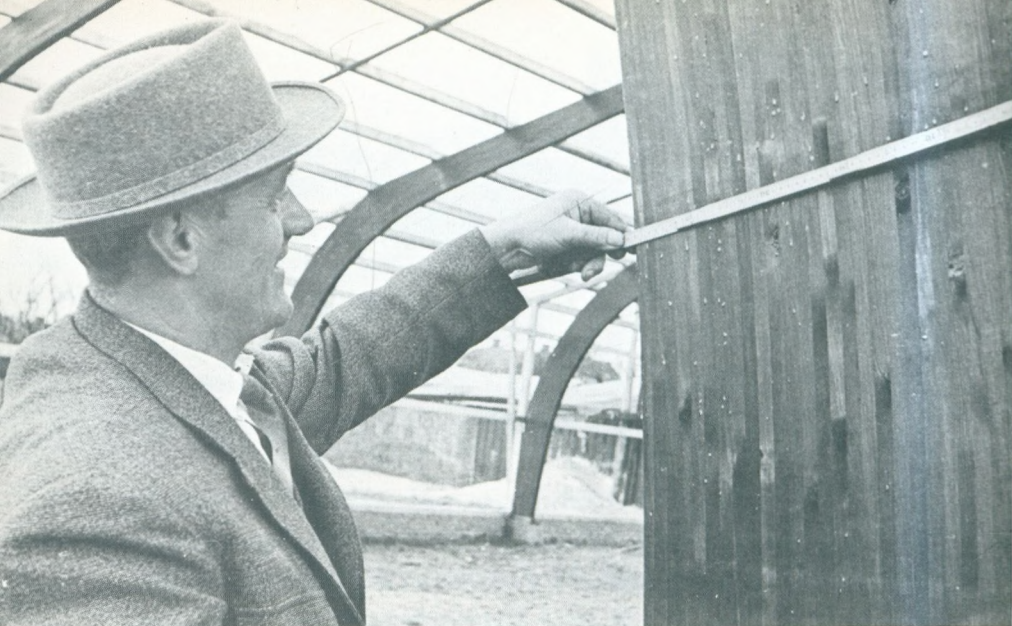
Laust Nielsen Jepsen (f. 1910) ved opførelsen af den første fabriks-hal i Brede. Tonhalle Foto.
