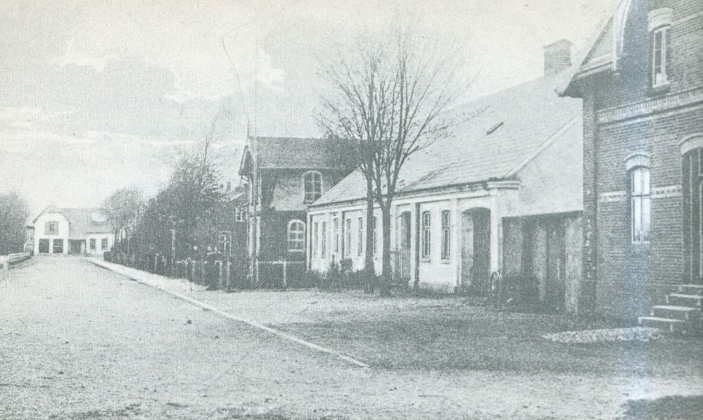
Jernbanegade o. 1910. T.h. ses bryggeriet, opført 1887, senere el-værk fra ca. 1920 til 1935, derefter kommunekontor. T.v. herfor mejeriet, opført 1886. På de to bygningers grund ligger i dag det nye mejeri, opført i 1950'erne.
