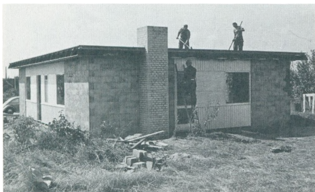
CP-hus under opførelse på Hejmdals Allé i Kjersing. Fot. Knud Rasmussen, ca. 1960. Byhistorisk Arkiv.
