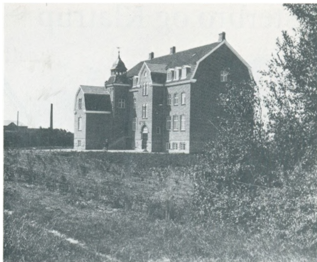
Gl. Vardevej 80, den gamle arbejderhøjskole, umiddelbart efter opførelsen 1917. Byhistorisk Arkiv.
