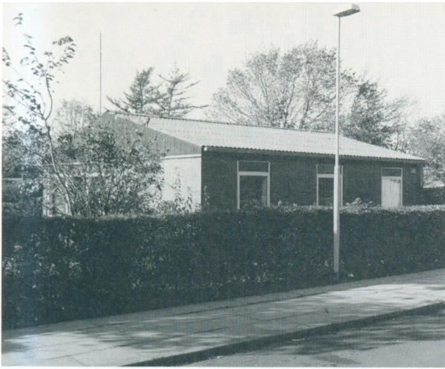
De socialfilantropiske småhuse, bygget ved Rosenvængets Alle 1961-62 (ark. Mads Kamp).
