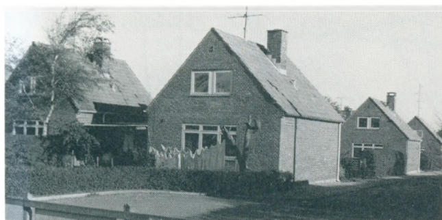
Det socialfilantropiske byggeselskabs første huse, Pile- og Poppelvej.
