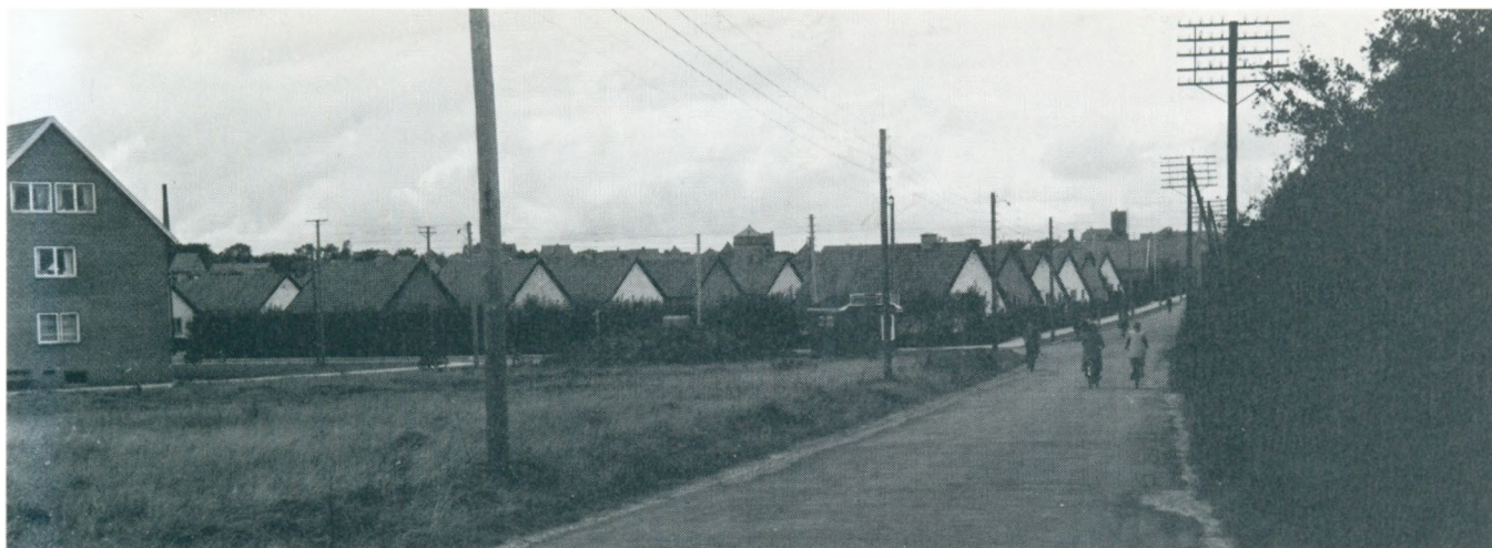
»Parcelhusene« ved Brorsonsvej-Kingosvej, set fra Gammelby Strandvej ca. 1948. Byhistorisk Arkiv.
