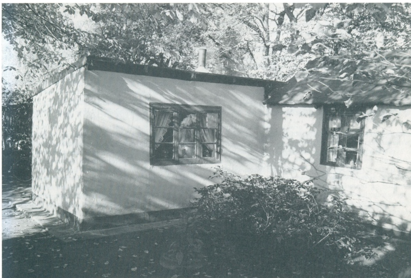
Havehus på Blichers Alle, bygget 1926-27 af en havnearbejder til en familie med 5 børn. Nedrevet 1988. Fot. Brian Kristensen 1986.
