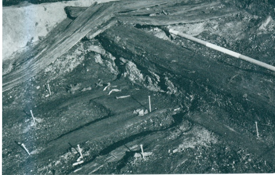
Fig. 13. Bevaret bræddegulv i våningshuset.
