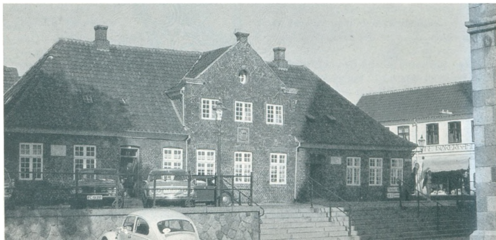
Den gamle latinskole ved Ribe Domkirke
