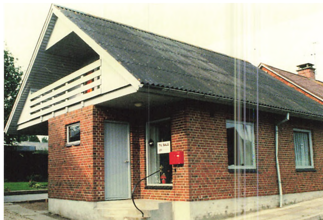
Klokkevej 3 fotograferet i 1978, efter at huset er blevet renoveret.
