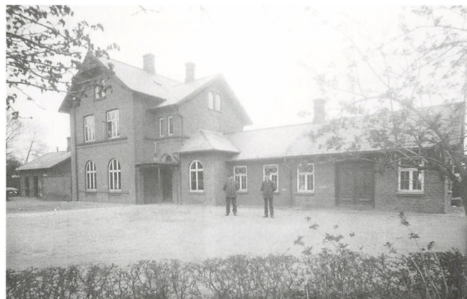
Skive Nord set fra Aagade. Foran bygningen står portør Thestrup til venstre og stationsmester Harly til højre. 1915.
