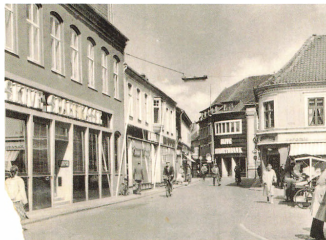
Torvet i Skive med karnappen over Buemanns forretning.
