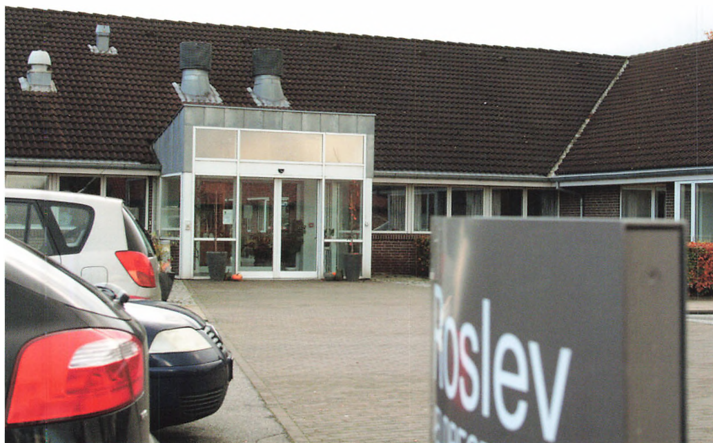
Det nuværende ældrecenter blev bygget i en frugtplantage og har hovedindgang fra Æblevej. Foto: Privat
