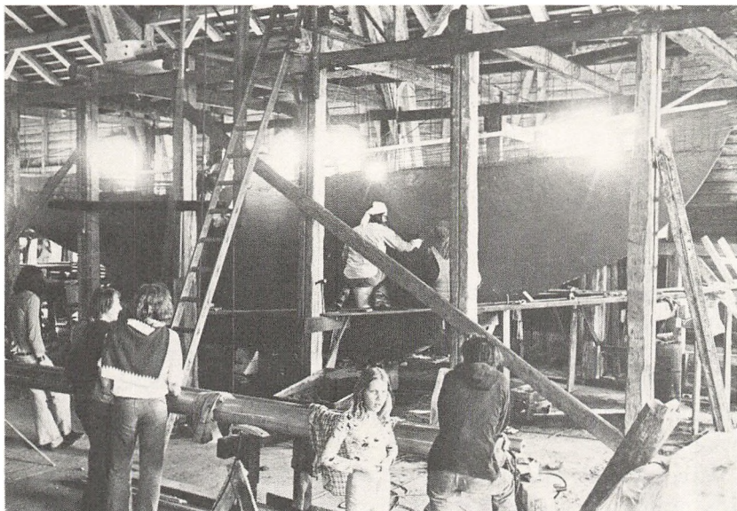
Nogle christianitter er i gang med at bygge en båd af beton i Den grønne hal.
