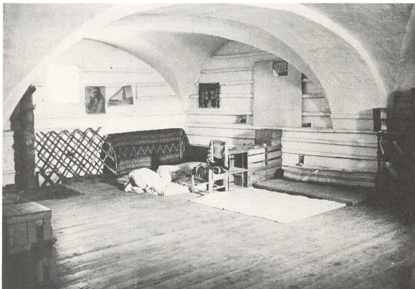
Den øverste etage i Krudthuset, hvor en familie har indrettet soveværelse.
