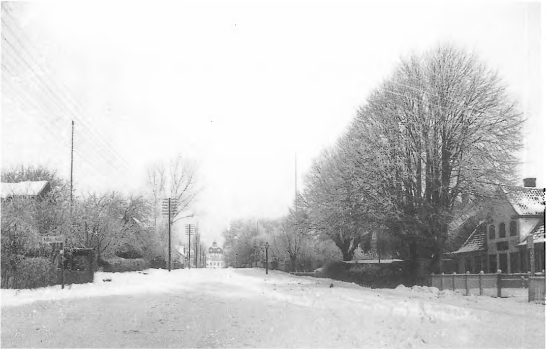
Slotsgade i sne. Til højre ses købmandsgården, Slotsgade 17. Foto: Christian Linde, uden år.
