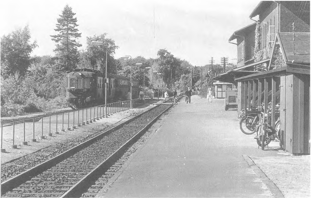
Fredensborg Station. Til højre holder et dieselelektrisk tog, som blev indsat på strækningen Hillerød-Helsingør 1933. Til højre ses det cykelskur, som grundejerforeningen byggede i 1940. Foto, 1980'erne.
