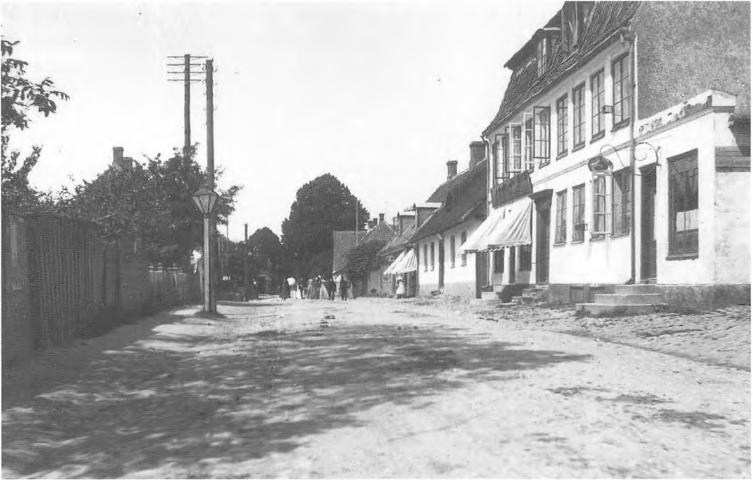
Jernbanegade som grusvej med brostensrender langs kanterne og høje trappestene. T.v. ses en gadelygte til olie. T.h. ses "Pontoppidans Gård", nr. 13 og Fredensborg Skole med stråtag, nr. 11, der blev nedrevet i 1907. Foto, ca. 1905.
