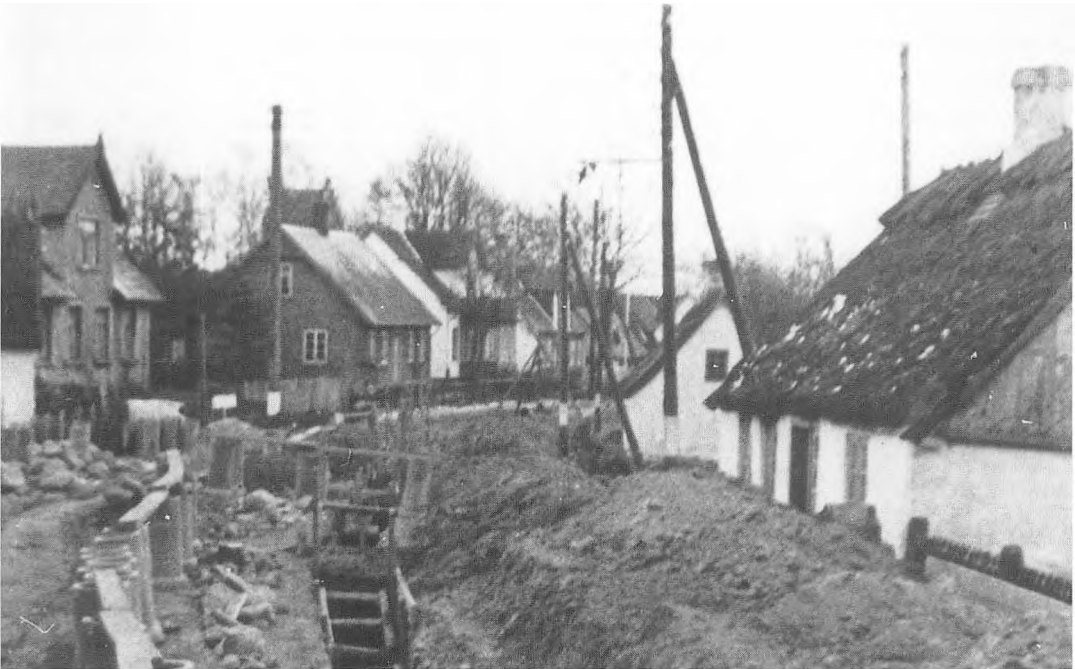
Asminderødgade opgraves i anledning af kloakledningernes omlægning til frostfri dybde. Foto: Hans Otto Krogh, ca. 1942.
