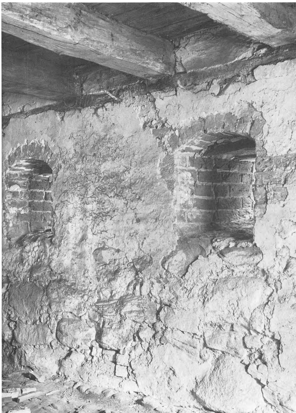
Del af underetagens magasinrum med to af nordsidens tragtformede lys- og luftspalter.
