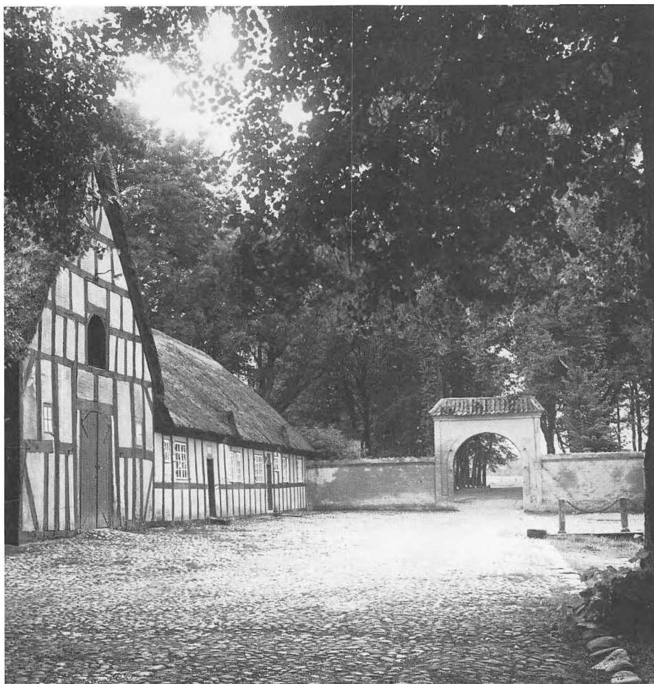
Tjeles vestre port med den nordvestre staldgårdslænge og den gamle hestestalds nordgavl.
