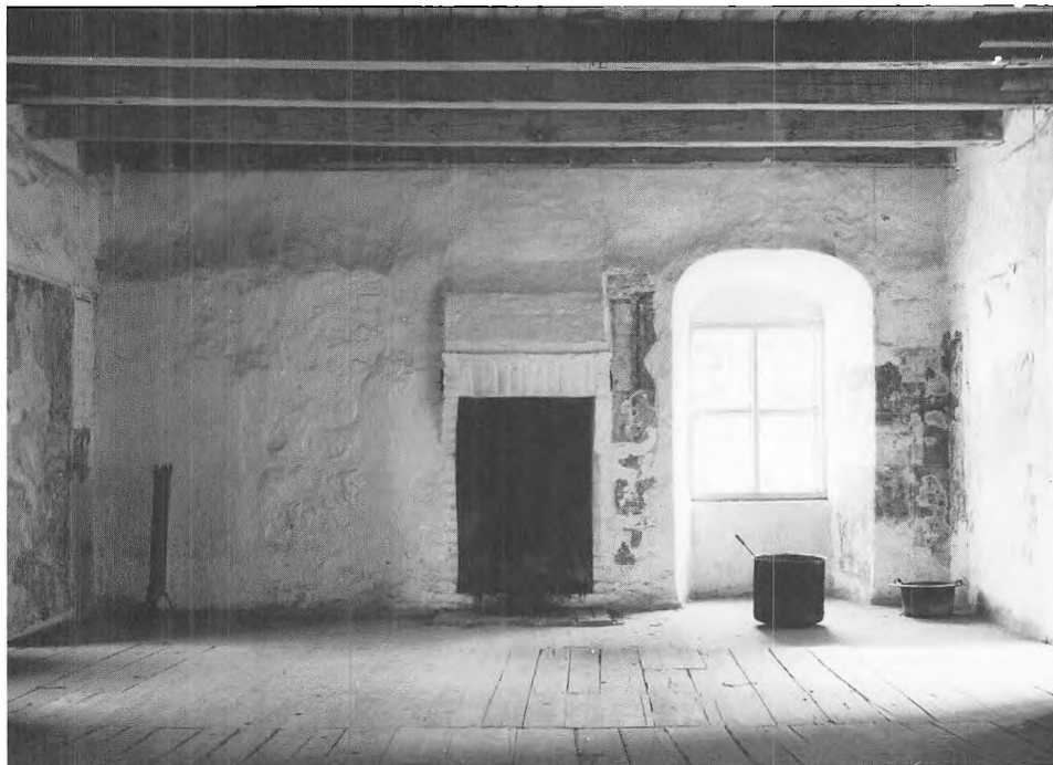
Sønnerhusets overetage som den ser ud i dag. Bemærk den oprindelige kamin, kalkmaleriesterne fra 1560-70 og det kurvehanksbuede vindue fra den sidste ombygning (1585-90?).
