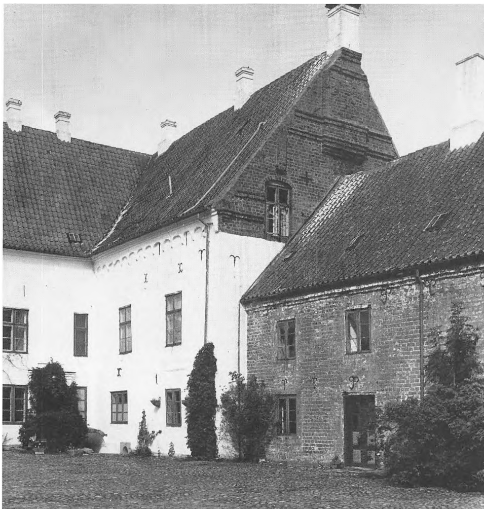
Det østre hus' vestside og sydgavl. Til højre den lave østre længes grundmurede gårdside.
