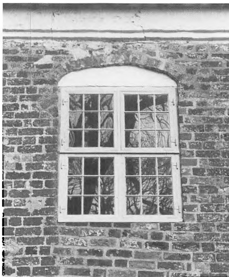
Sønderhusets sydvestre vindue, i hvis venstre side der indgår en 12 skifter høj fals samt lidt af fladbuestikket hidrørende fra det oprindelige vindue.
