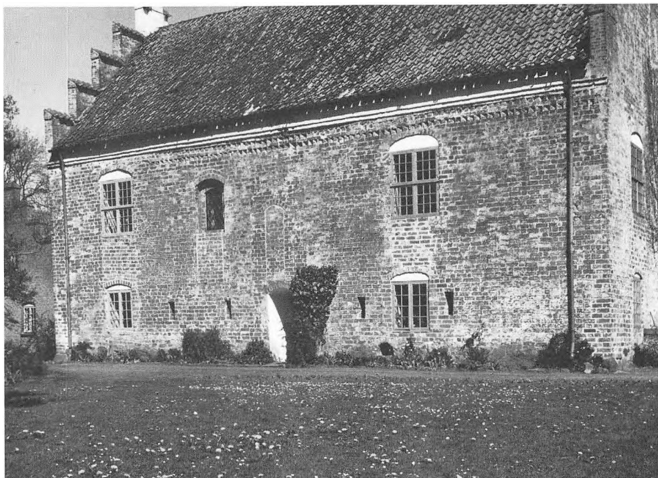
Sønderhusets sydside. Bemærk stueetagens lys- og luftspalter og det opr. vindue i 2. etage.
