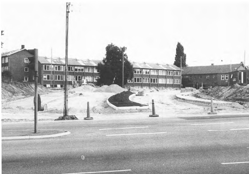
Fig. 12. Her er den forlagte Kildebakkegårds Allé ved at blive ført ud i Hovedgaden i september 1981, hvor tidligere Buddinge Hovedgade begyndte. I baggrunden ses etagehusene i det tidligere sving på Kildebakkegårds Allé. De ligger, hvor Jean Kunze fra 1910 havde et handelsgartneri, som senere blev overtaget af sønnen Knud Kunze. Overalt i Gladsaxe Kommune prægedes billedet – ikke mindst i kvarteret omkring Kildebakkegårds Allé – af handelsgartnerne, som leverede varer til Københavns Grønttorv året rundt.
