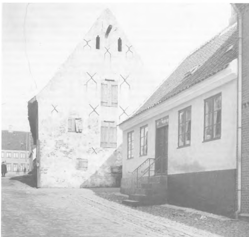
Fig. 3. Kompagnihusets sydgavl før restaureringen i 1920'erne.
