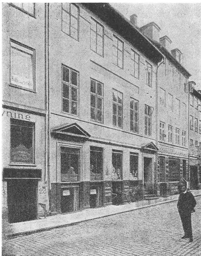
Bagernes Laugshus i Læderstræde, hvor Det tekniske Selskab stiftedes i 1843, og hvor Det tekniske Institut havde til Huse indtil 1881.
