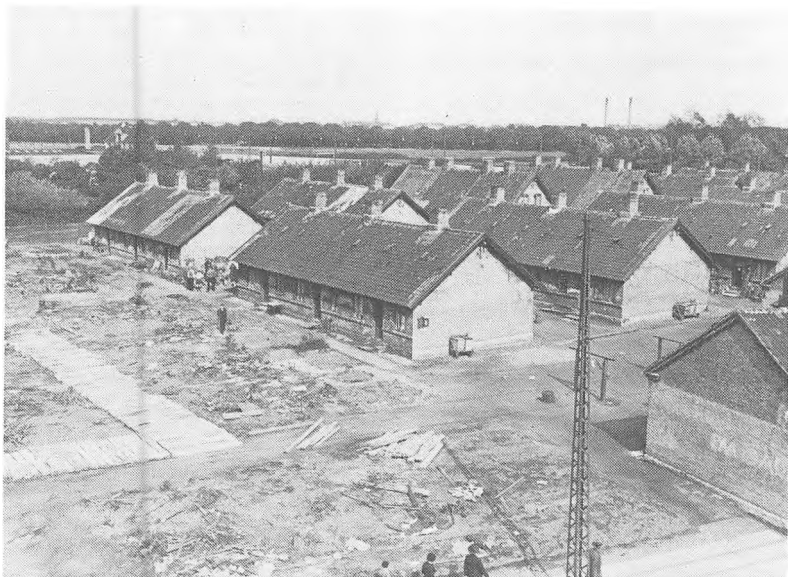
Hovedparten af bygningerne fra 1. byggetape, fotograferet i maj 1934. Københavns Bymuseum.
