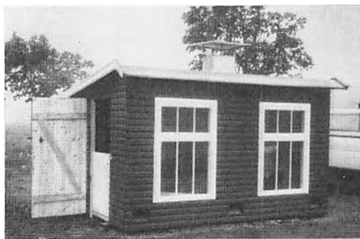
Et smukt Kyllingehus. Man ser Aabningerne til Indsugning af Luften, og en Halvdør inden for Døren for at undgaa Træk.
